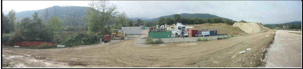
Vista area di cantiere
