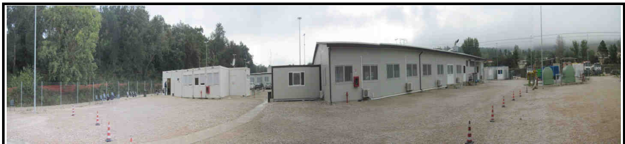
edificio svago e mensa
