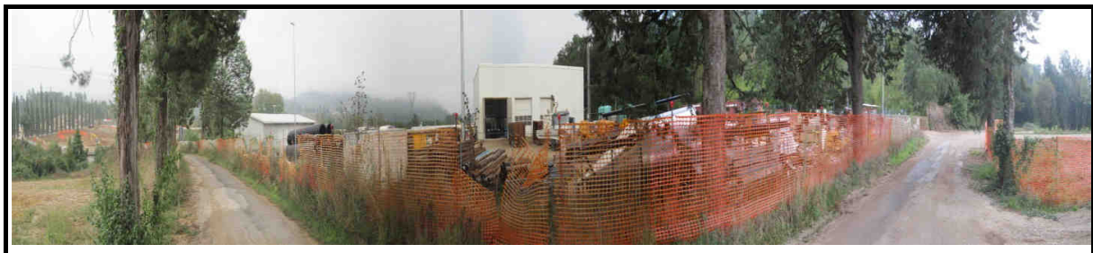
campo base operativo - lato nord
