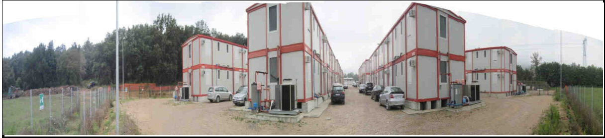
dormitori - lato sud
