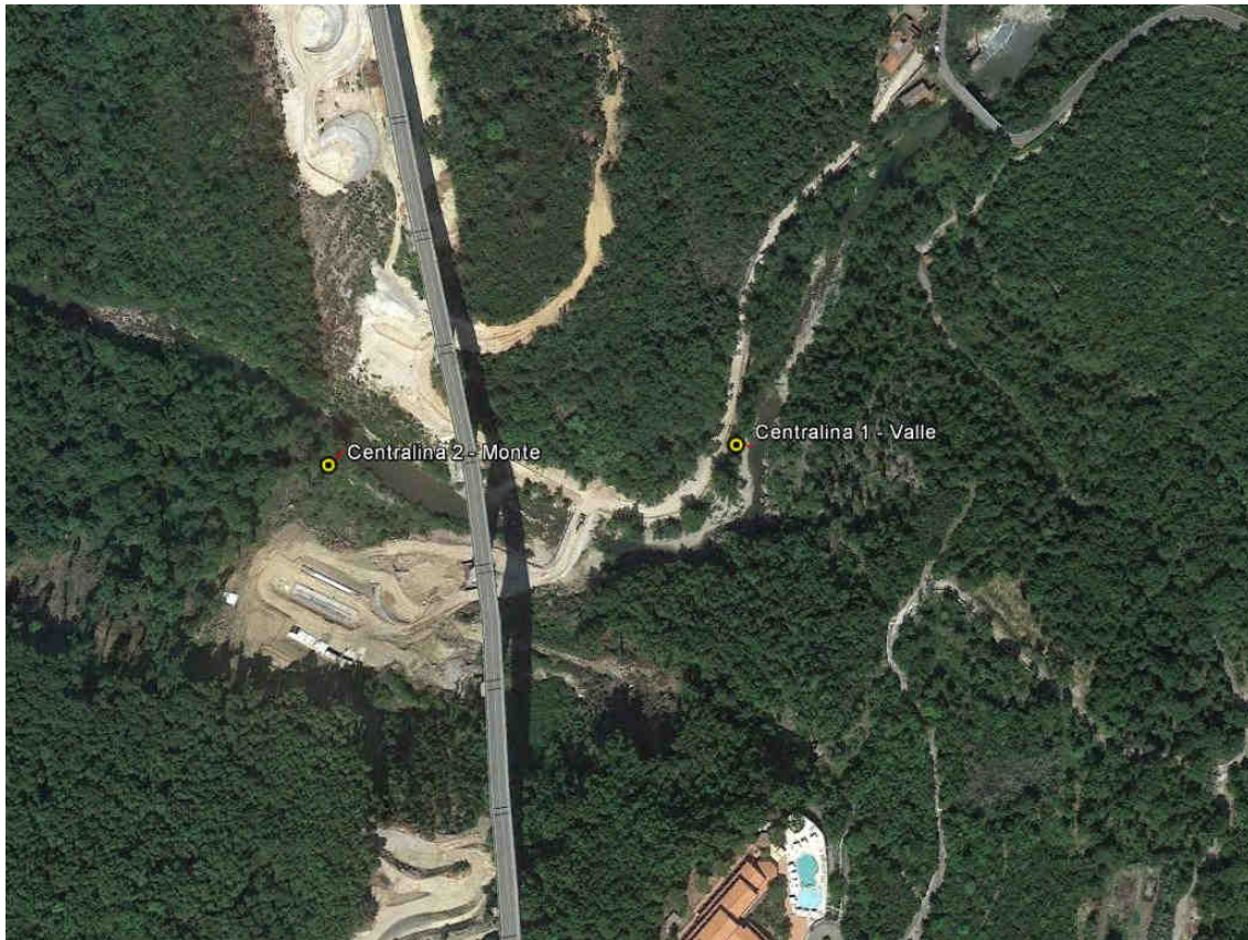
Figura 39 – Vista globale del sito di indagine
