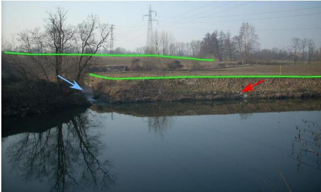
*Fig. 4 - Fiume Lambro a monte del ponte dell'A1 a San Zenone al Lambro. Sono visibili due ordini di terrazzi evidenziati dalle linee verdi, l'immissione della Roggia Viscontea indicata dalla freccia azzurra e difese spondali indicate dalla freccia rossa.*
