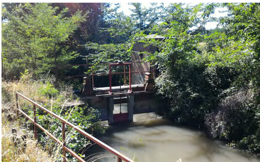
Figura 20 – Situazione della chiusa a valle del viadotto autostradale sul cavo Sillaro Salerano in occasione del sopralluogo effettuato nel Luglio 2017
