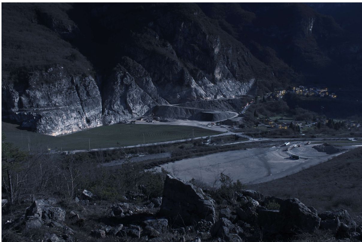
Figura 67 vista notturna area Pedemonte (di fronte all'abitato di Casotto)
