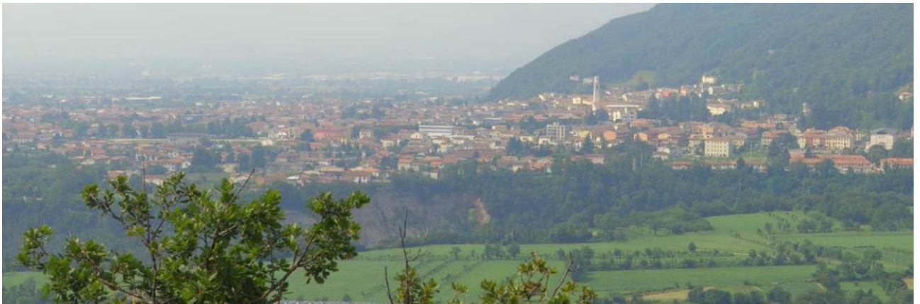
Figura 24: Panoramica in prossimità del viadotto Piovene
