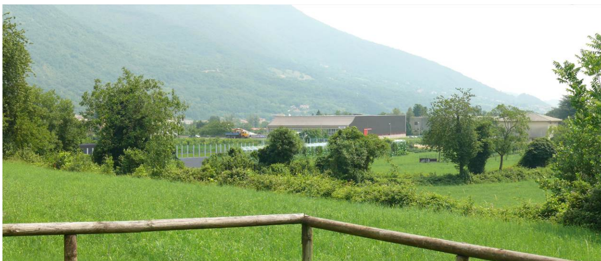
Figura 73: Le barriere acustiche trasparenti in PMMA collocate in sommità trincea aperta tra S. Agata 1 e S. Agata2.
