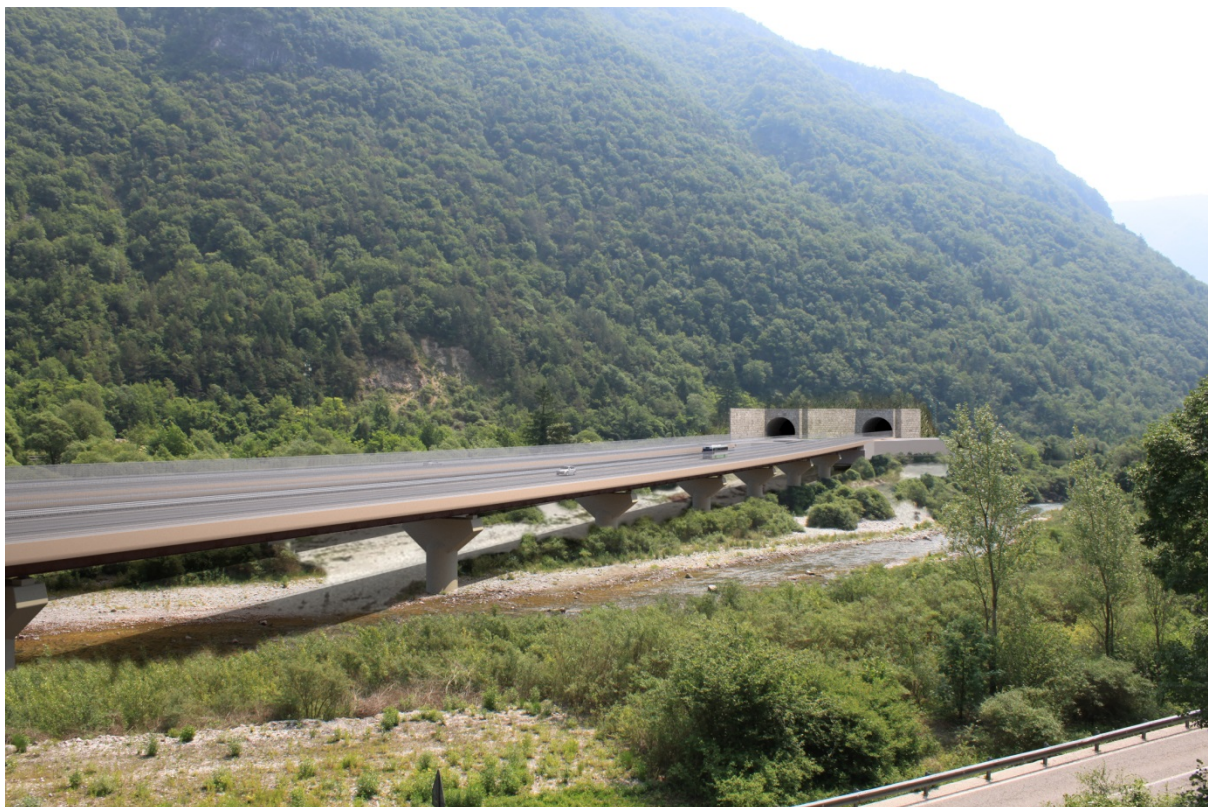
Figura 54 Viadotta Settecà: fotosimulazione dopo 5 anni dall'ultimazione dei lavori
