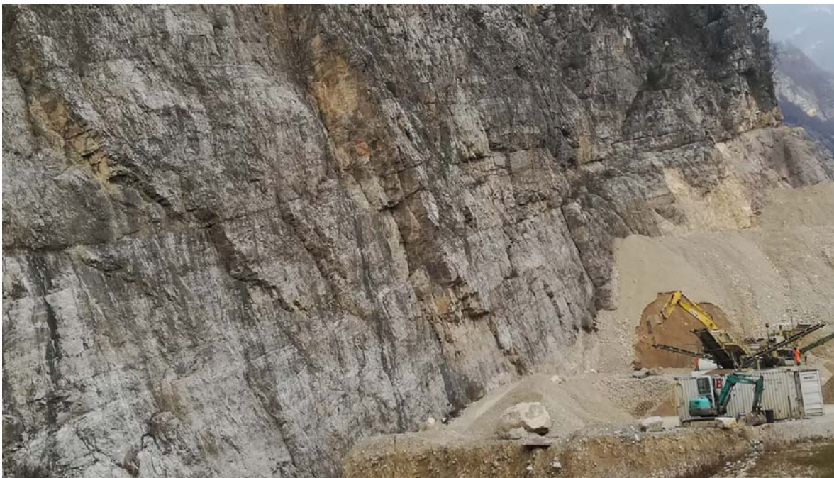
Figura 8 – Assetto strutturale caratterizzato da giacitura degli strati suborizzontale. Si osserva una famiglia di discontinuità subverticale orientata parallelamente al fronte
