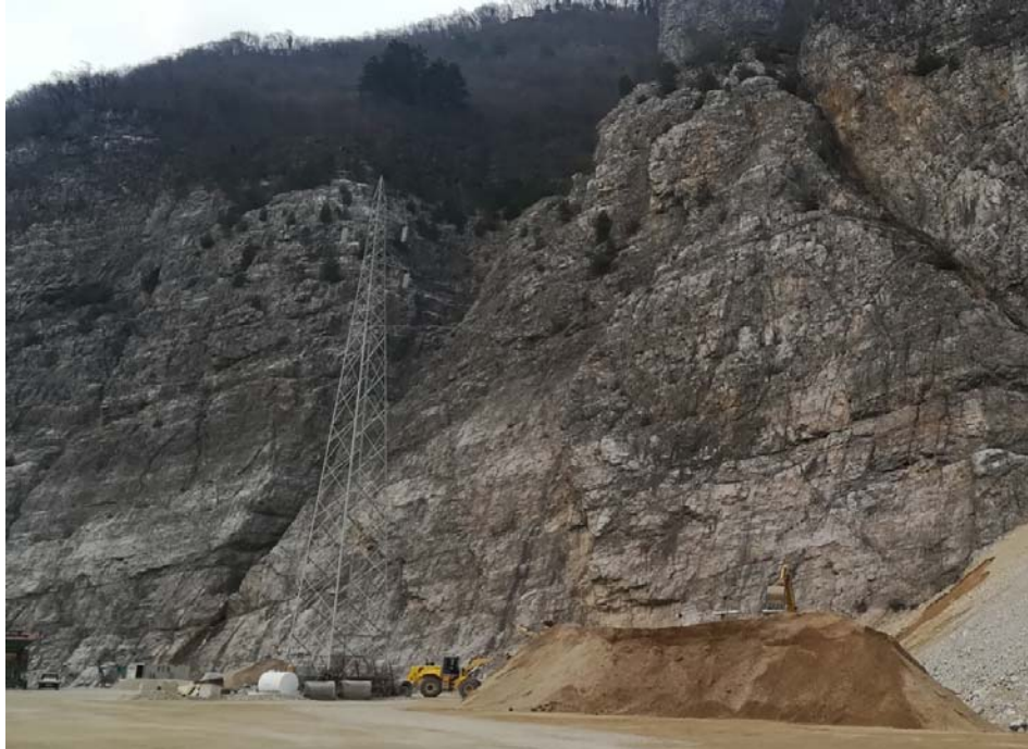
Figura 7 – Parete sovrastante il settore di svincolo
