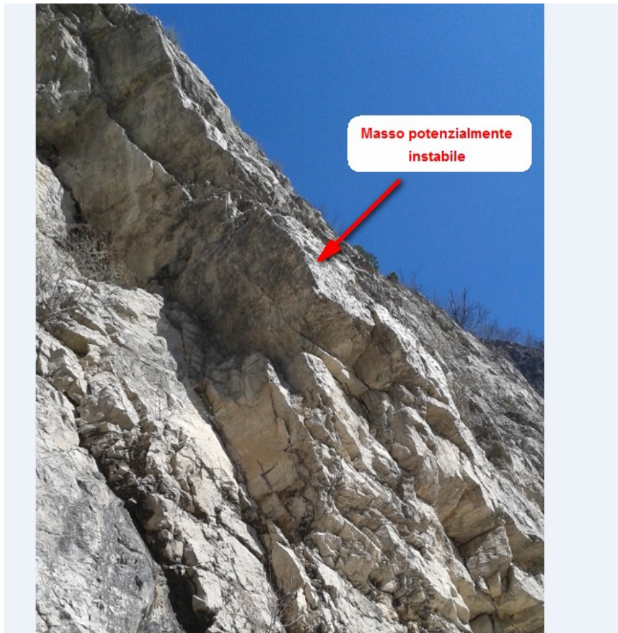
Figura 5 – Masso potenzialmente instabile riscontrato durante il rilievo in parete
