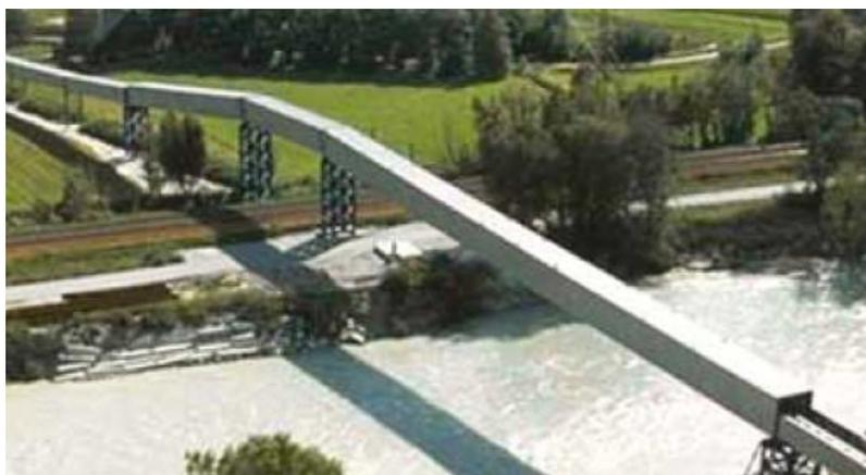
Come già detto nei capitoli descrittivi delle aree di cantiere, al fine di limitare i flussi dei mezzi pesanti sulla viabilità esistente e la dispersione di polveri, si prevede l'utilizzo di nastri trasportatori per il conferimento alle aree di stoccaggio o lavorazione del materiale prevalentemente proveniente dagli scavi delle gallerie.
