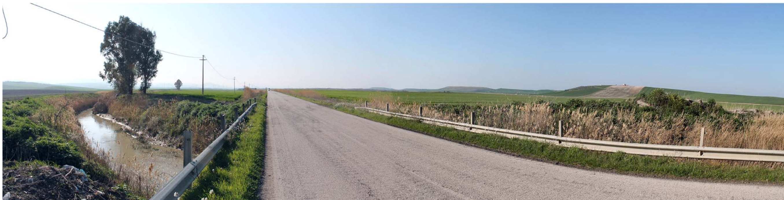
Panoramica 11 _ Vista dalla SP 106 Giardinetto-Palazzo d'Ascoli, in prossimità del ponte sul Torrente Carapellotto _ Stato di fatto
