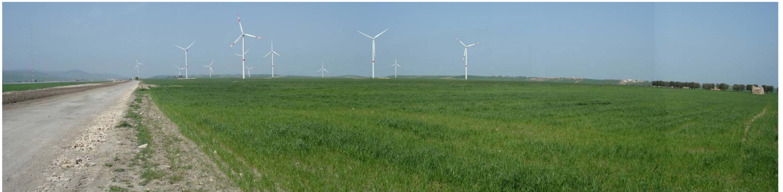
In alto, la Stazione Elettrica 380/150 kV di Deliceto; in basso, impianto eolico in agro di Deliceto lungo la SP 103 verso Castelluccio dei Sauri.
