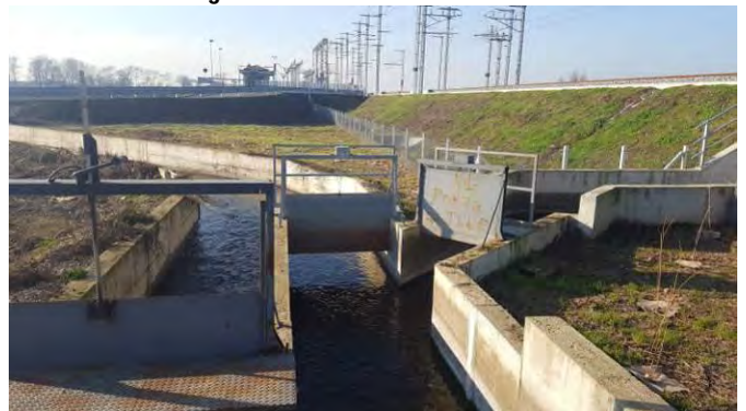
Figura 2.1.60 – Particolare all'uscita del AV-RI11-FA7-07-Sud
