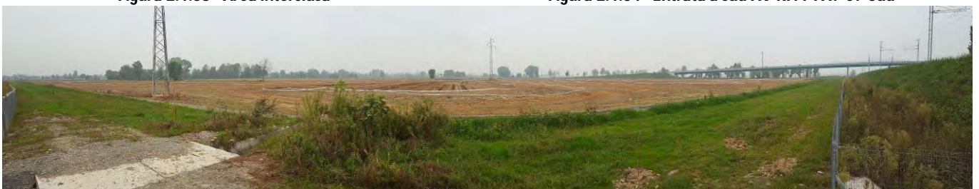
Figura 2.1.55 - Panoramica dell'ambiente a sud dei passaggi fauna della stazione 7
