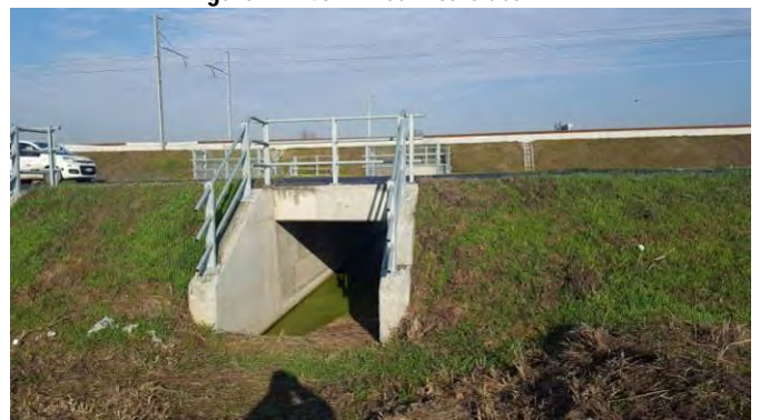
Figura 2.1.42 - Entrata a sud AV-RI04-FA7-05-Sud
