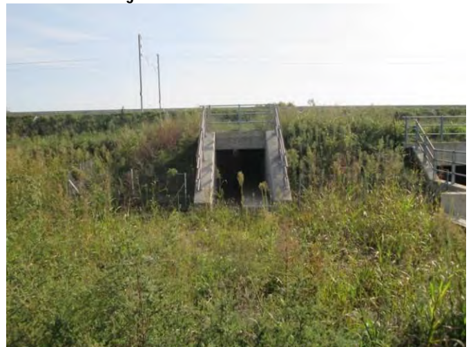
Figura 2.1.30 - Uscita a sud AV-RI06-FA7-03-Sud
