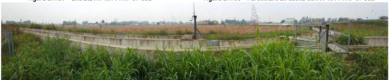
Figura 2.1.61 - Panoramica dell'ambiente a sud dei passaggi fauna della stazione 8
