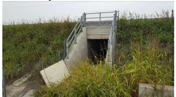
Figura 2.1.54 - Entrata a sud AV-RI11-FA7-07-Sud
