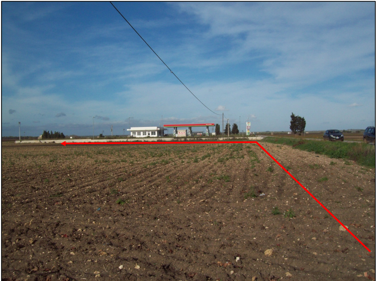
Foto 2: Panoramica generale del metanodotto in progetto
