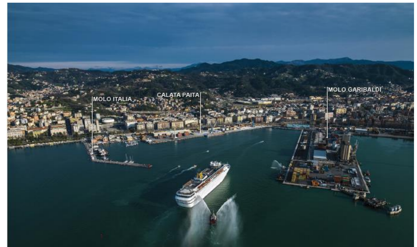
FIGURA 4-200 – FOTOGRAFIA AEREA DELL'AREA DI INTERVENTO – PUNTO DI RIPRESA DA SUD
