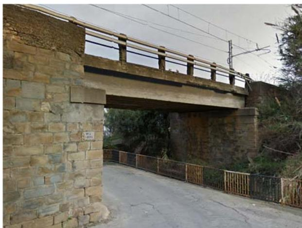
Tra il sottopasso ferroviario ed il canale in gabbioni si è prevista un'opera di raccordo in c.a di 15,0 m di lunghezza con sezione iniziale rettangolare di dimensioni 2,83 m in larghezza (pari alla larghezza
