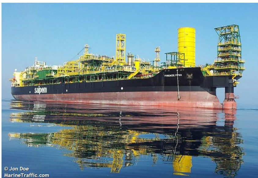
Figura 7.2 - FPSO Firenze, a servizio dei pozzi del campo Aquila di Eni (concessione F.C2.AG)
