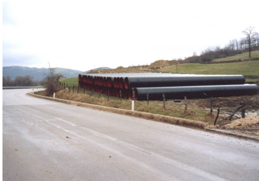
Fig. 3.1.A: Esempio di piazzola di accatastamento tubazioni
