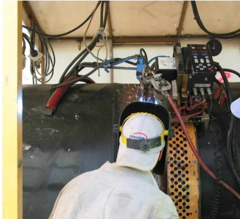
Fig. 3.1.D: Esempio di saldatura di linea
