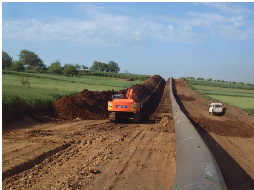
Fig. 3.1.E: Esempio di scavo in trincea
