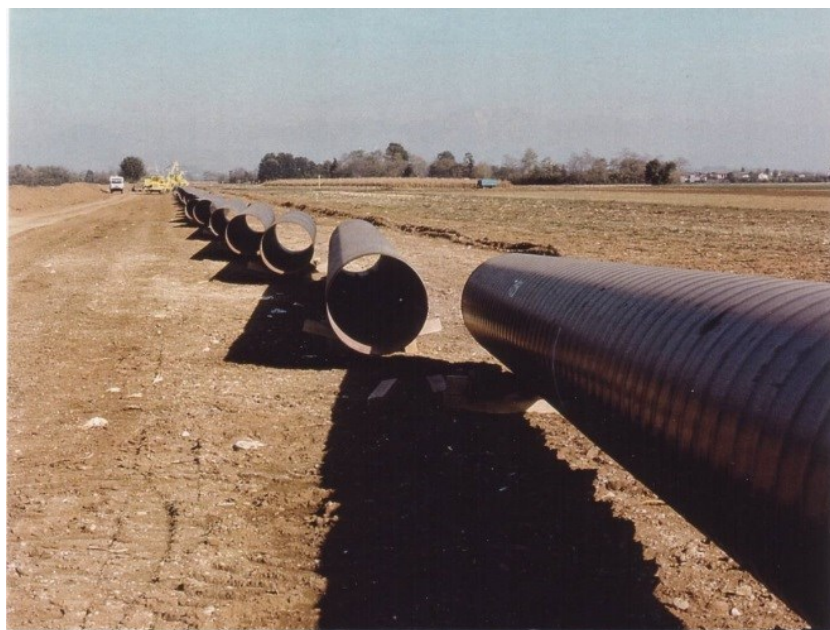
Fig. 3.1.C: Esempio di sfilamento tubazioni
