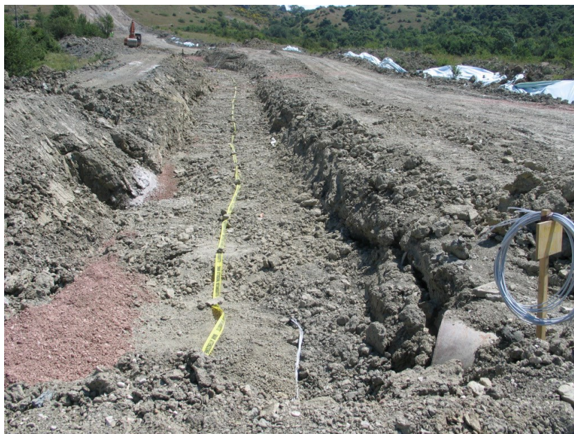
Fig. 3.1.G: Esempio di rinterro della condotta
