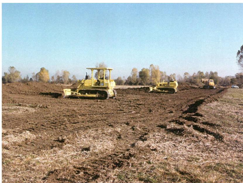
**Fig. 2/B: Esempio di apertura dell'area di passaggio**
