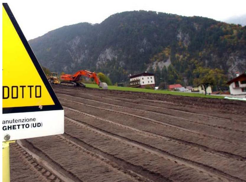
**Fig. 2/F: Esempio di redistribuzione dello strato humico**
