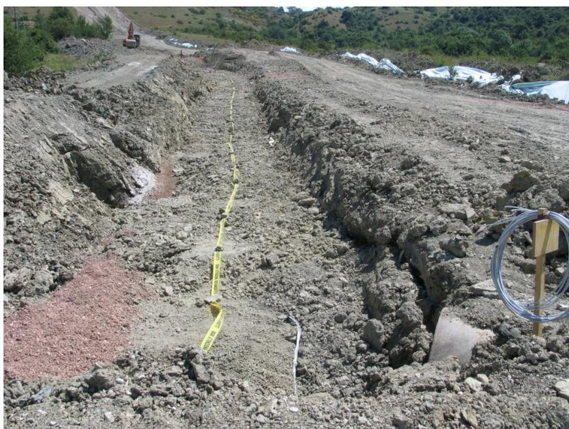
**Fig. 2/E: Esempio di rinterro della condotta**
