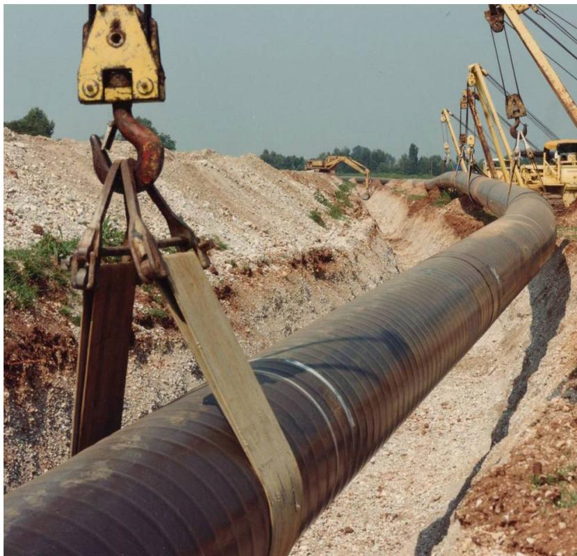
**Fig. 2/D: Esempio di posa della condotta**
