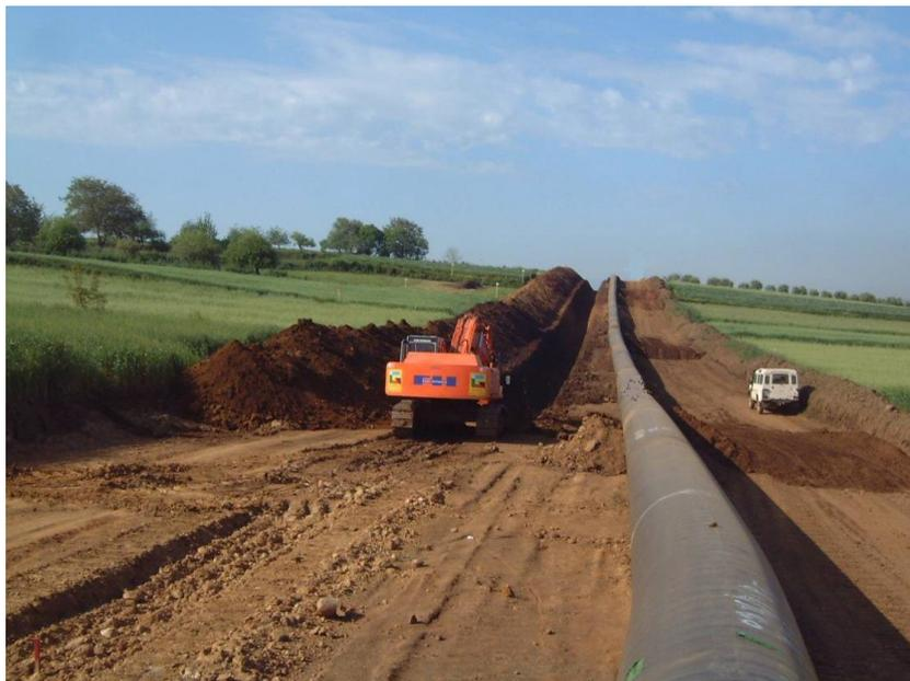
**Fig. 2/C: Esempio di scavo in trincea**
