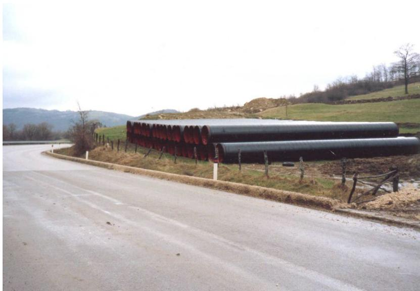
**Fig. 2/A: Esempio di piazzola di accatastamento tubazioni**
