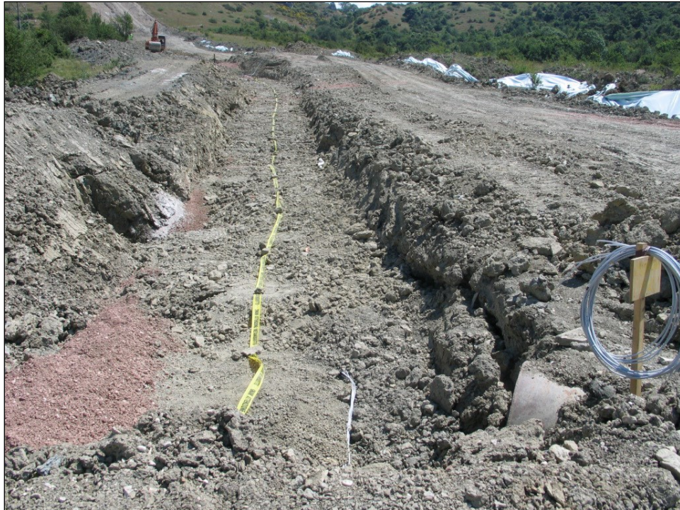
Fig. 2.1.G: Esempio di rinterro della condotta
