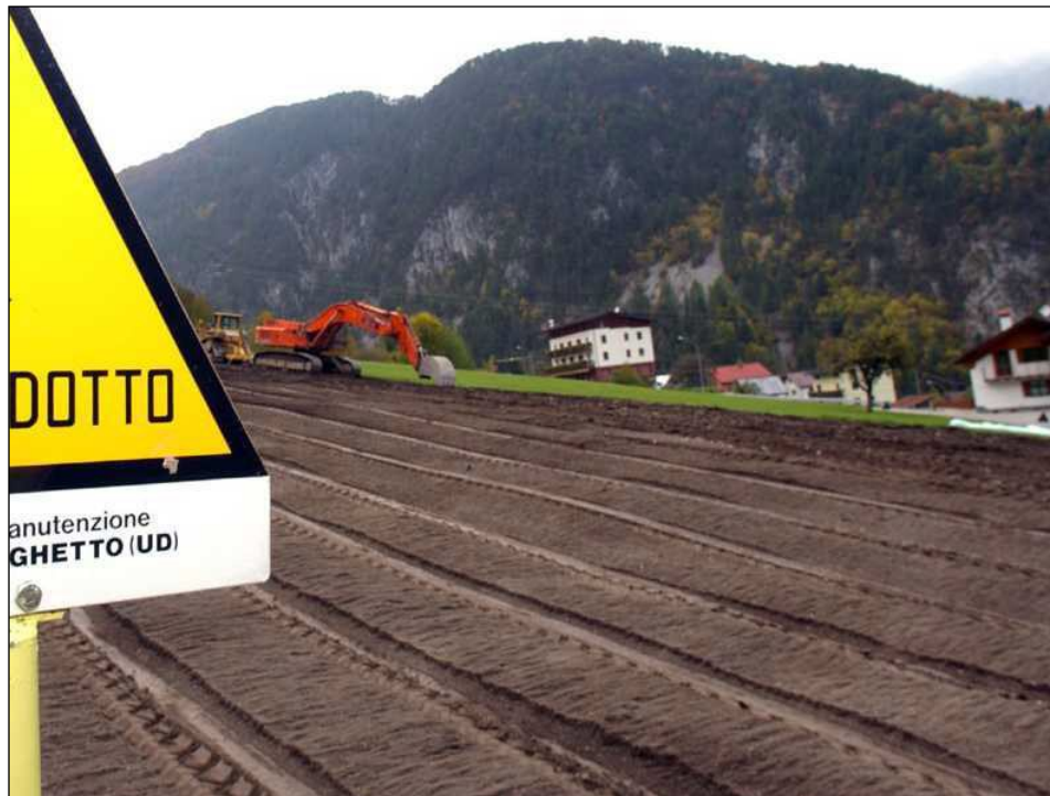
Fig. 2.1.H: Esempio di redistribuzione dello strato superficiale di suolo (topsoil)
