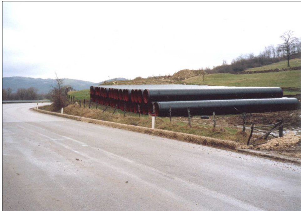
Fig. 2.1 A: Esempio di piazzola di accatastamento tubazioni
