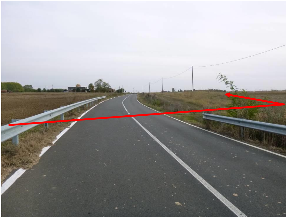
Foto n.35 – Attraversamento Strada Provinciale n.16 (con trivellazione spingi tubo) ed inizio parallelismo con Strada Provinciale n.16
