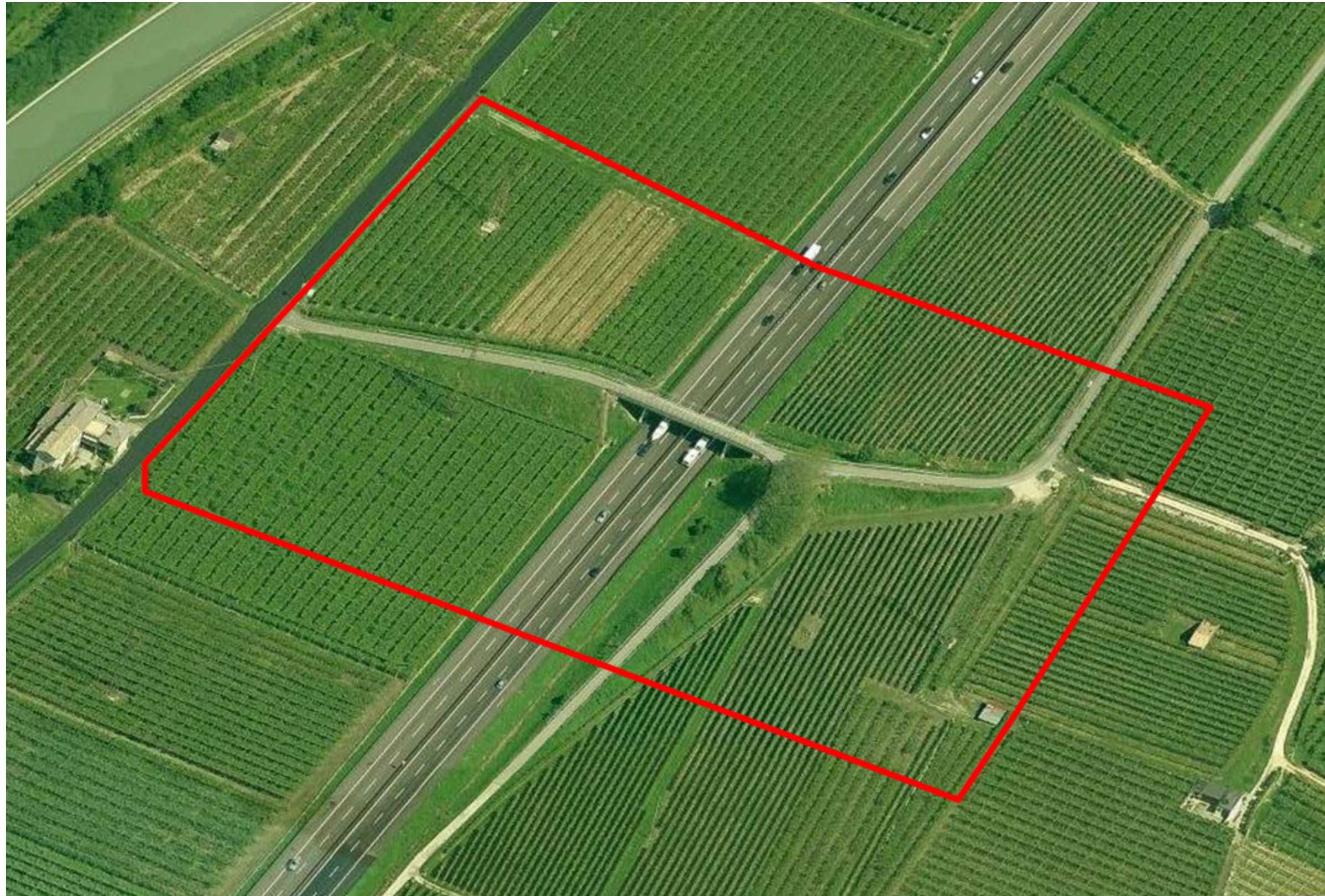
TAVOLA 6 - Veduta del sovrappasso n°64 (Bing Maps) con il perimetro all'interno del quale saranno ubicate le aree logistiche e di deposito
