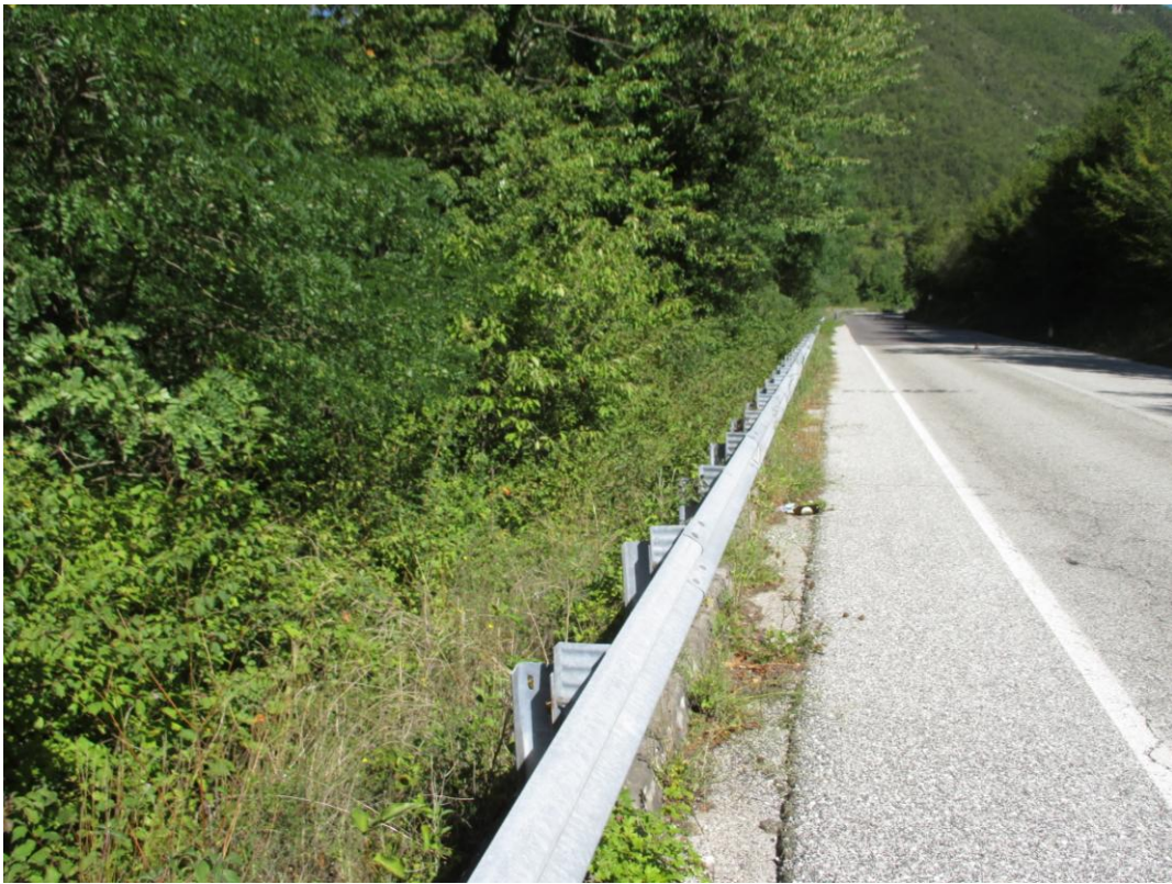
Figura 7 – Stato dei luoghi, percorso dal punto 2 al punto 3 (rif. Figura 1). Il cavo sarà posato sul lato sinistro della carreggiata, il gasdotto esistente è posato sul lato destro.
