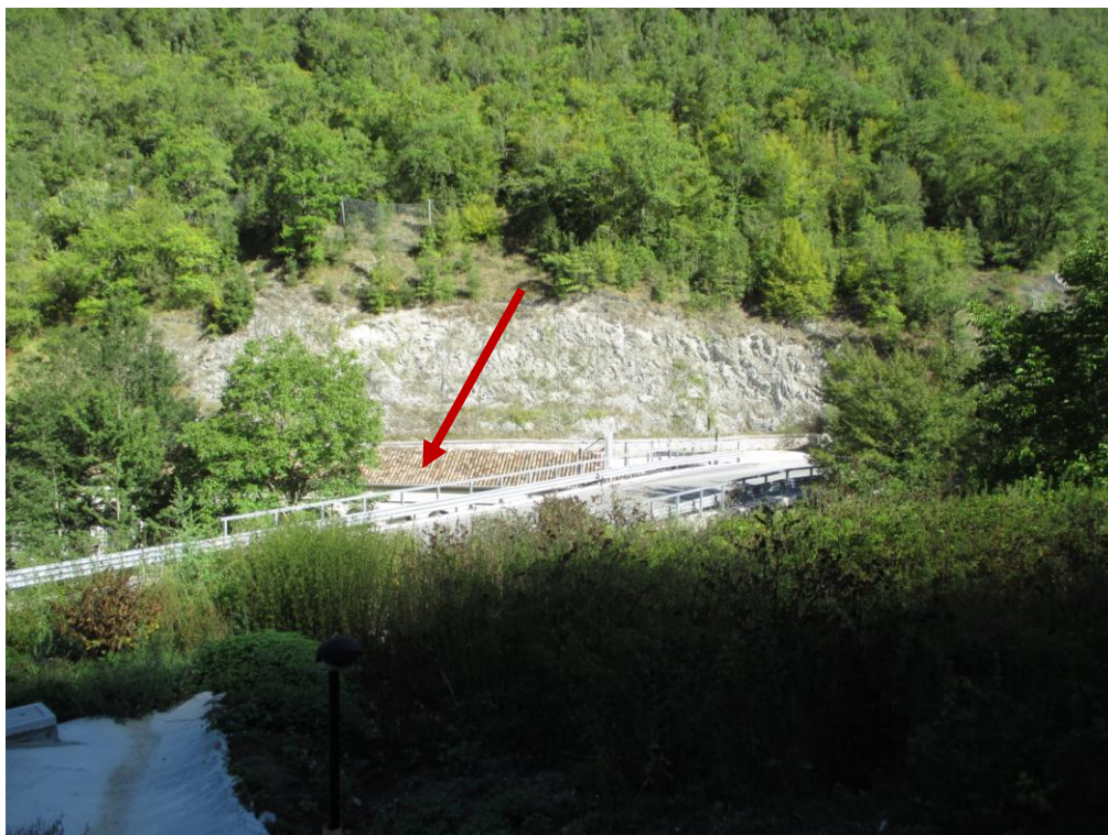
Figura 15 – Parte dell'edificio prossima alla strada del complesso termale Bagni Triponzo in cui sono presenti locali benessere (massaggi, trattamenti vari, etc), bagni e spogliatoi.
