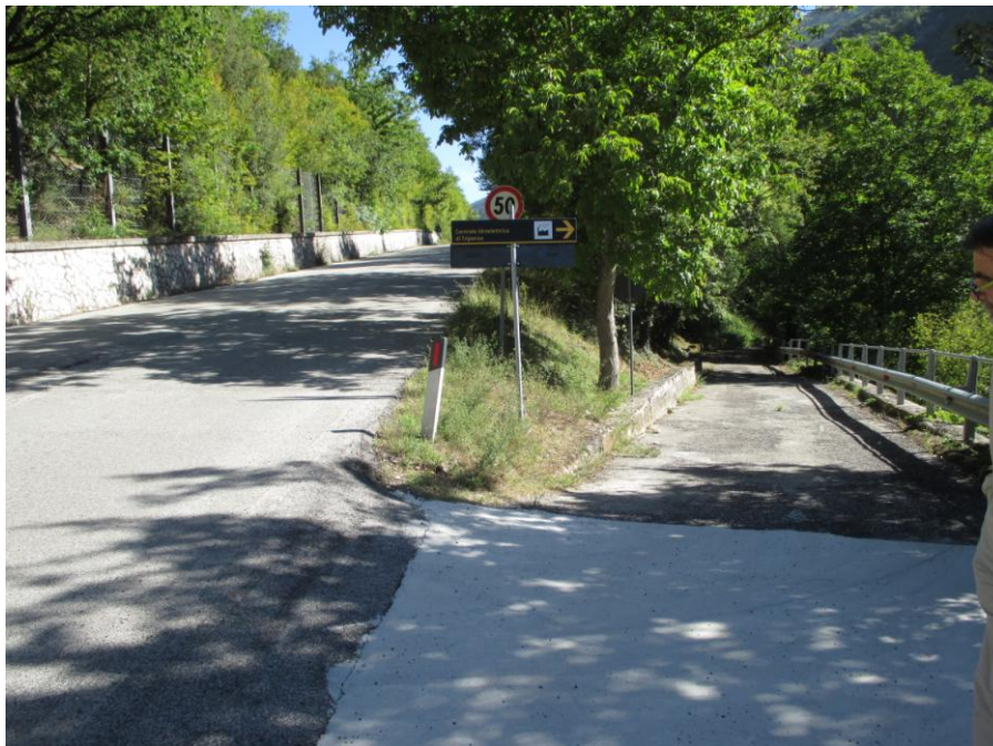
Figura 19 – Stato dei luoghi, strada privata di accesso alla Centrale idroelettrica di Triponzo (punto 7, rif. Figura 1).
