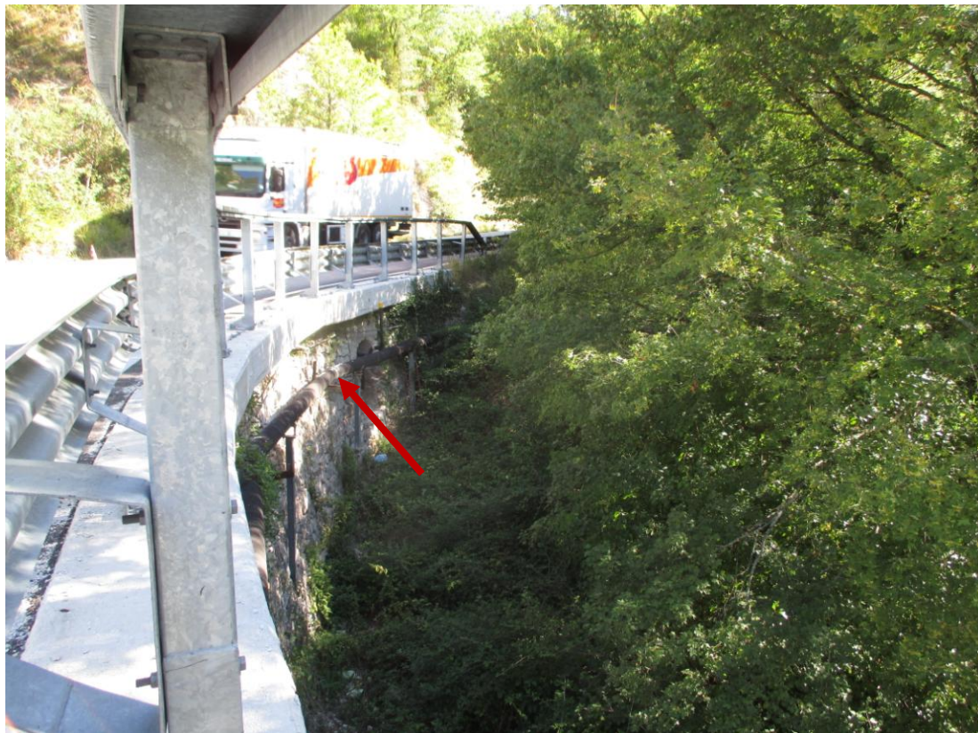
Figura 14 – Tratto di gasdotto fuori terra esistente in adiacenza al ponte.
