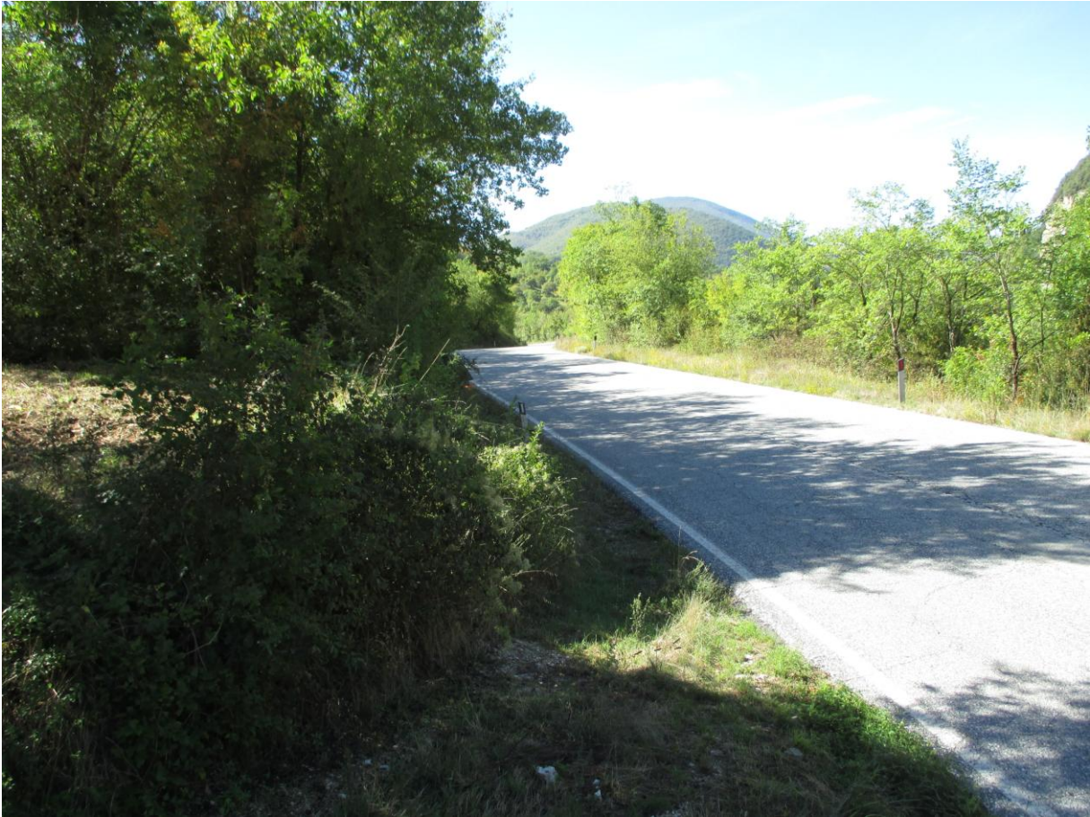
Figura 5 – Stato dei luoghi (punto D) – Attraversamento cavo 120 kV e gasdotto.
