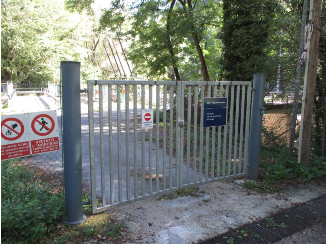
Figura 22 – stato dei luoghi – ingresso all'area della Centrale di Triponzo
