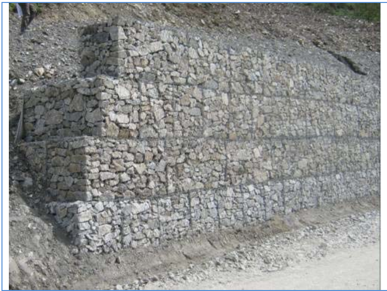
Esempio di opera in gabbioni - Fonte HE
