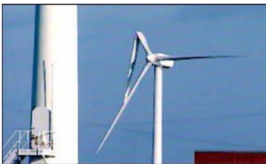
Esempio di rottura di pala senza distacco.
