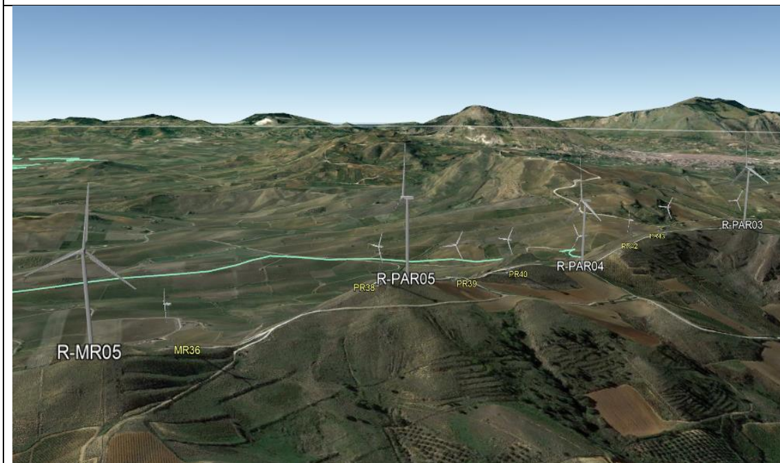
Vista degli aerogeneratori R-PAR03, R-PAR04, R-PAR05, R-MR05 (sullo sfondo si osservano i precedenti)
