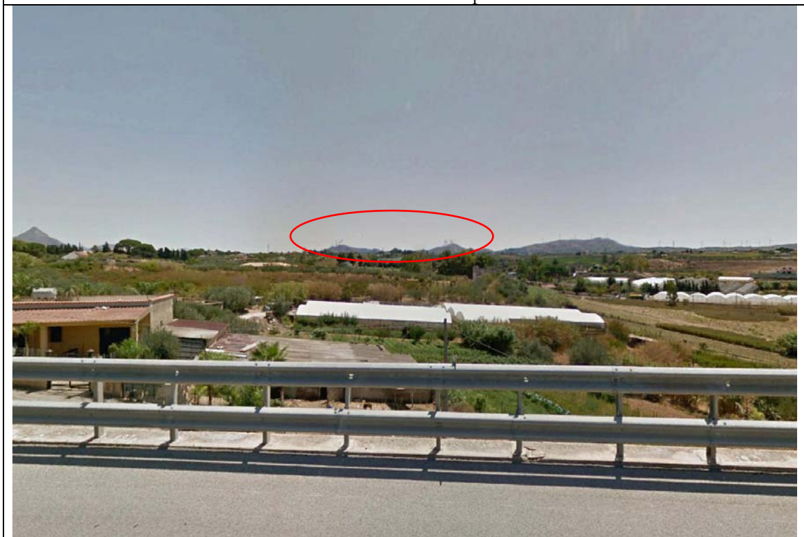
Foto 4 – A29 – post operam
