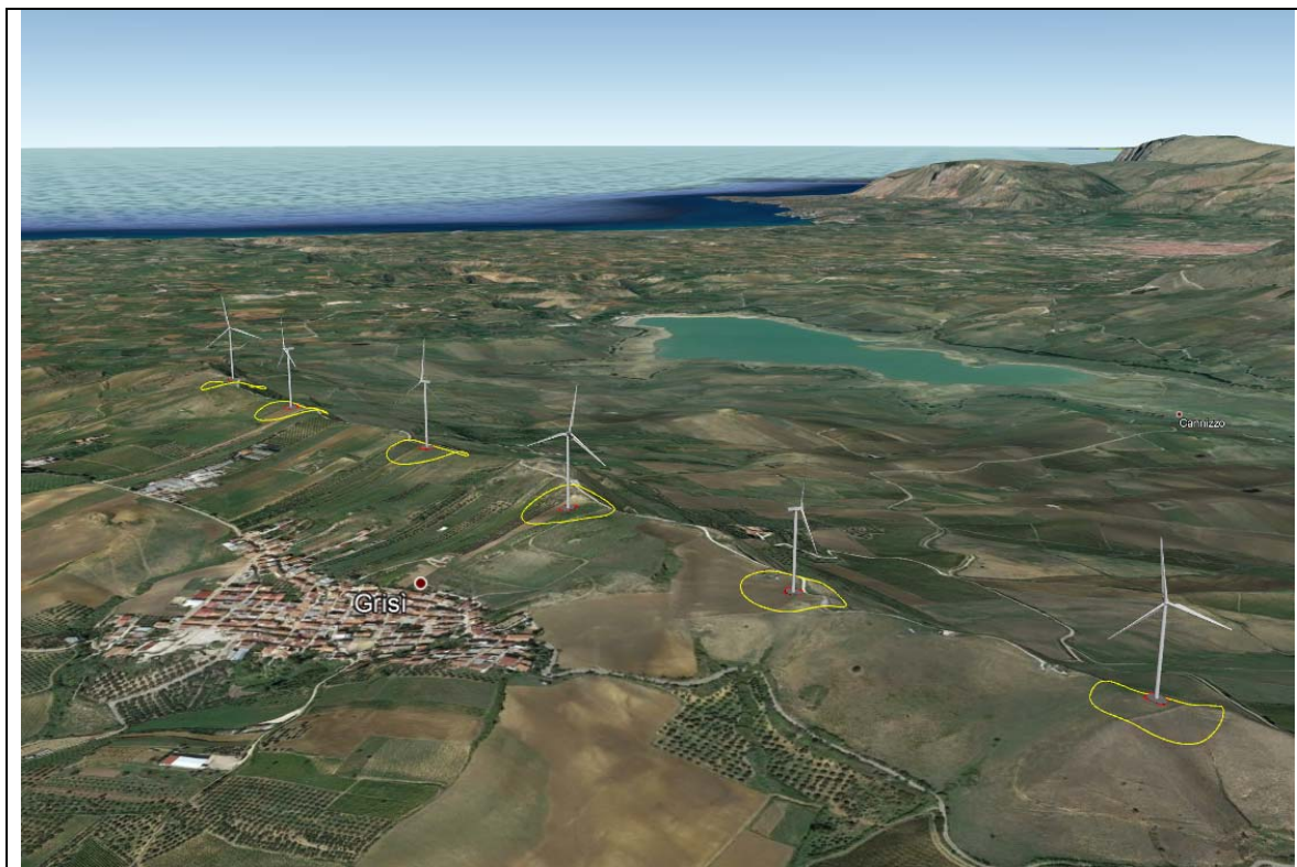
Vista degli aerogeneratori R-PAR01 (sullo sfondo) e a seguire R-PAR02, R-MR01, R-MR02, R-MR03, R-MR04
