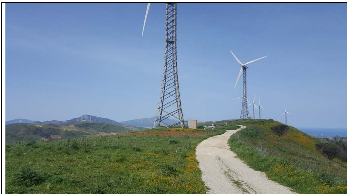
Panoramica del parco eolico esistente acquisita con Drone – fonte HE
