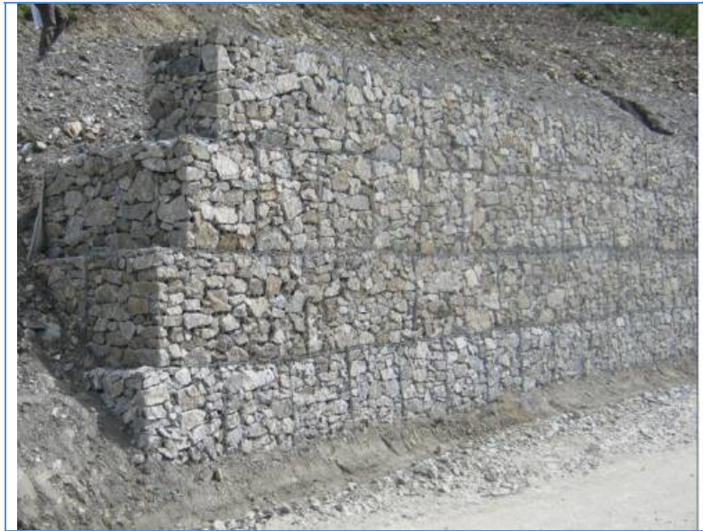
Esempio di opera in gabbioni - Fonte HE
