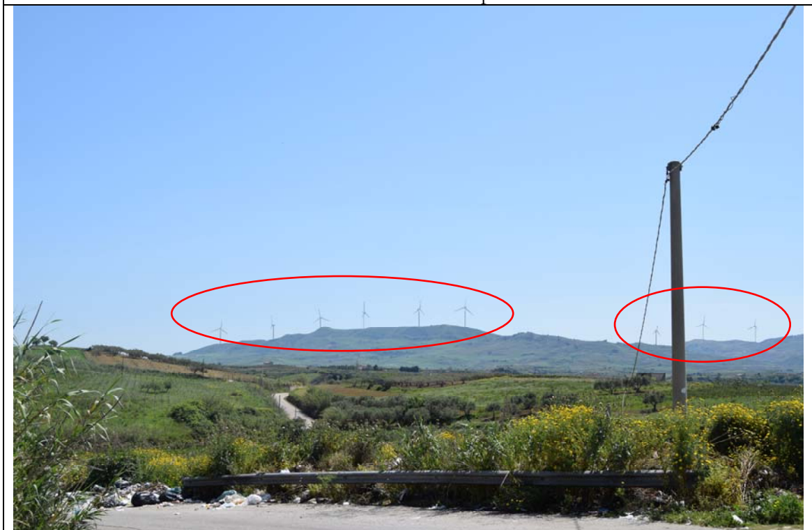
Foto 8 – SP39 – post operam
