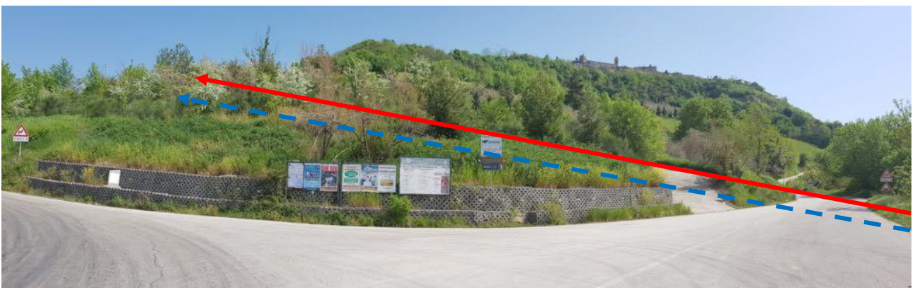
Foto 4 – Panoramica tratto variante in TOC nei pressi dell'incrocio tra SP e la strada comunale per Monterubbiano
