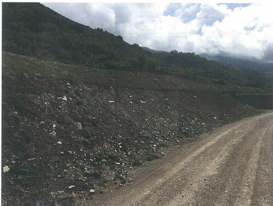
**Foto 6.3** - Terreni di riporto presenti lungo il vecchio tracciato autostradale, messi in posto per il mascheramento delle opere soggette a demolizione.
