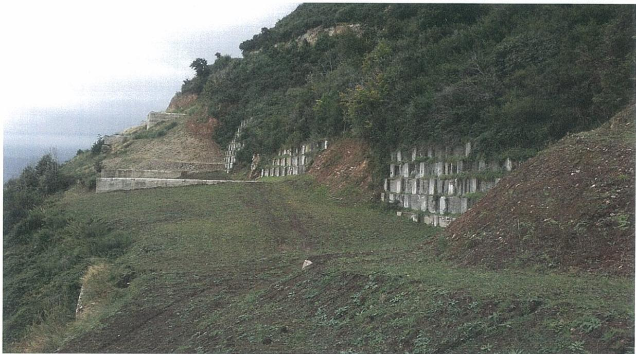
**Foto 6 e 6.7-** Vista delle opere fondali e di sostegno relative alle pile demolite del viadotto Costaviola (parte terminale) con evidenza dell'assetto morfologico dell'area di competenza e del ruolo stabilizzante che presentano tali opere nei confronti dei versanti
