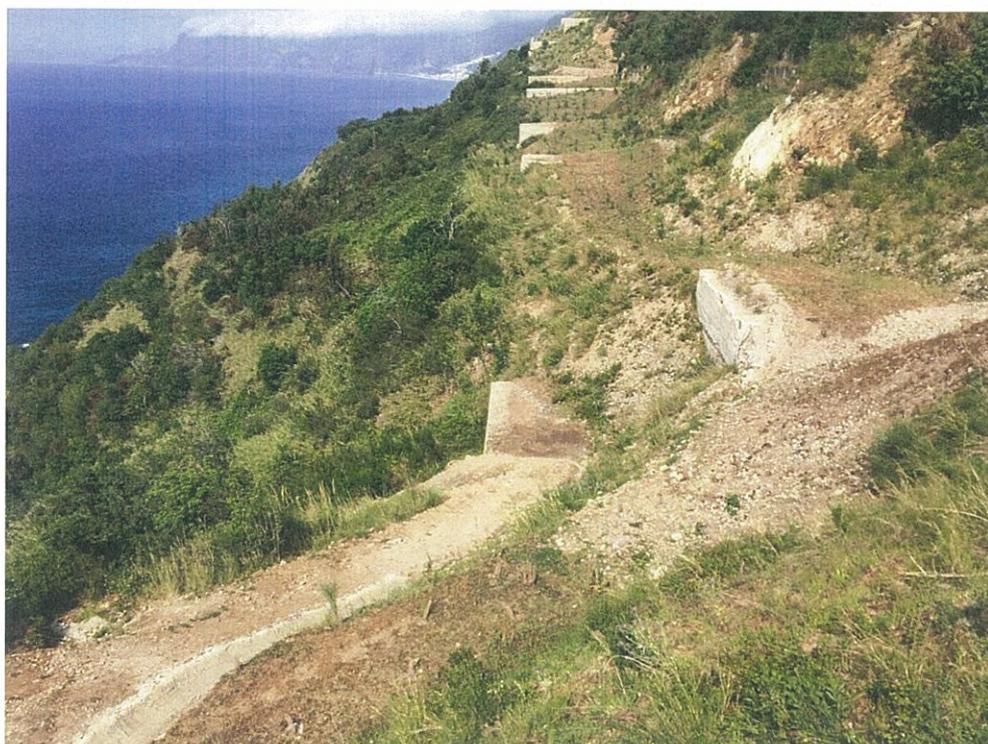
**Foto 6.8** – Vista dei versanti presenti nel comparto di interesse caratterizzati da pendenze elevate e da impluvi incisi, con i plinti presenti a seguito delle demolizioni del Viadotto Costaviola che contribuiscono alla salvaguardia degli stessi
