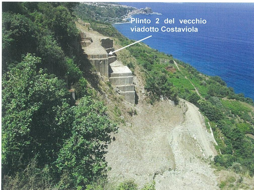
Foto 6.5 - Panoramica dalla spalla nord del viadotto Costaviola dismesso con presenza del Plinto n.2 a garantire un ruolo di sostegno alla porzione di versante posto a monte e caratterizzata da pendenze elevate.
