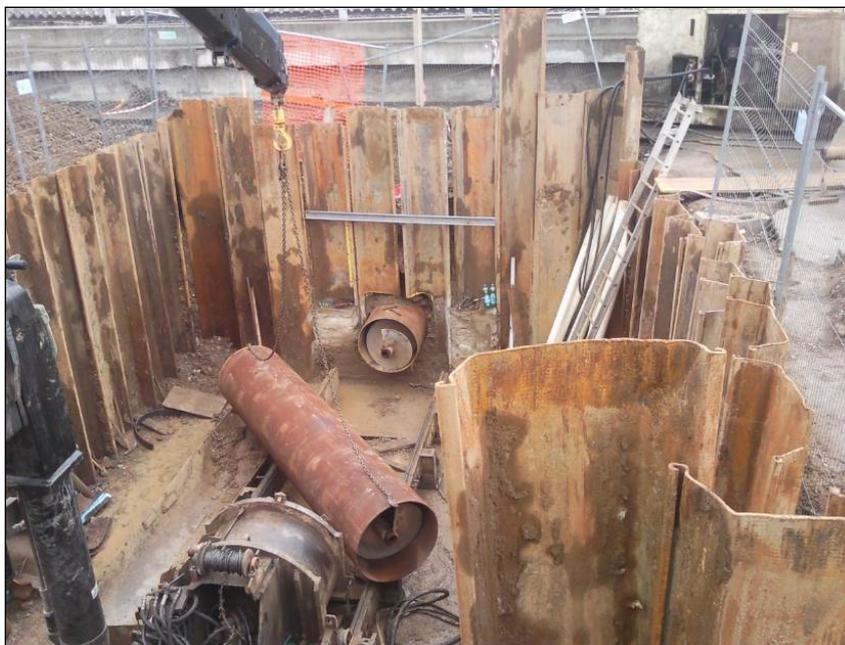
**Foto 4.5 – Buca di spinta per trivella spingitubo sostenuta da palancole**
