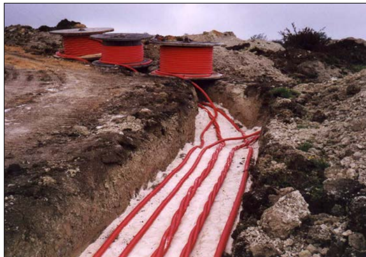
Particolare posa cavi elettrici.
