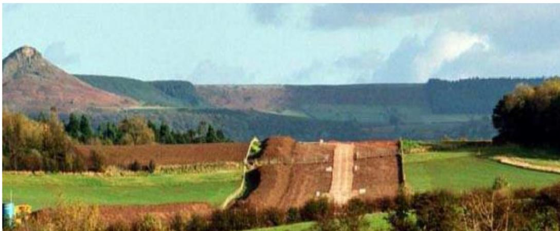
*Figura 3.5: Area di asservimento per la messa in opera del cavo a corrente continua*
