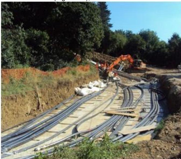
*Figura 3.2: Fascia di asservimento per la messa in posa del cavo in corrente continua*
