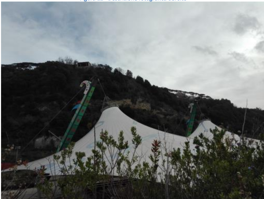
Figura 13 - Descrizione fotografica del sito
