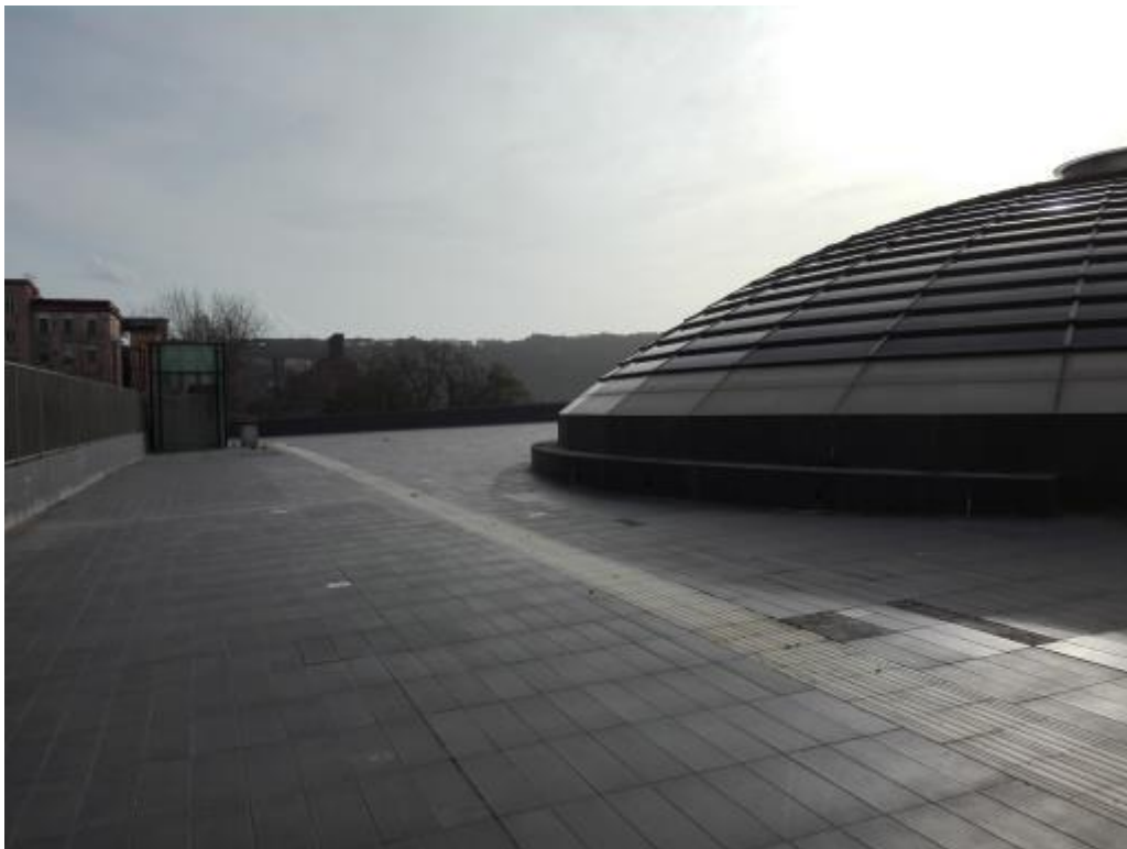
Figura 10 - Descrizione fotografica del sito
