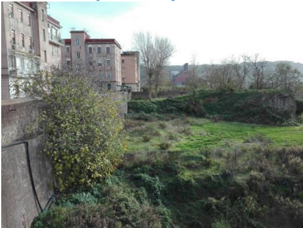
Figura 11 - Descrizione fotografica del sito
