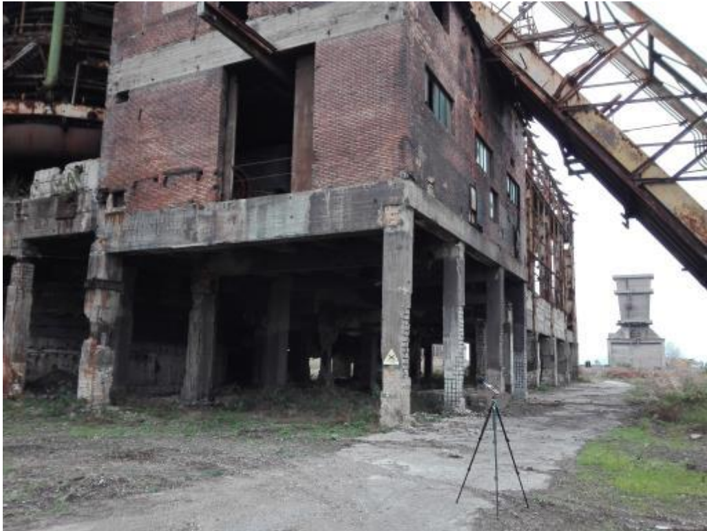
Figura 10 - Descrizione fotografica del sito
