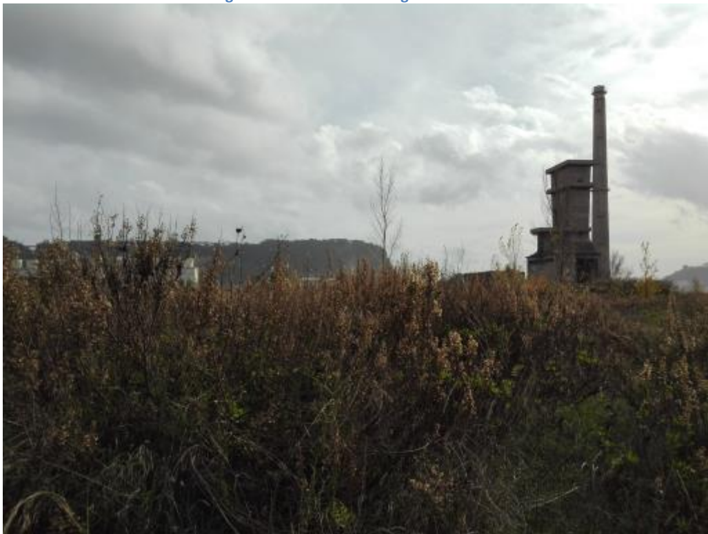
Figura 11 - Descrizione fotografica del sito
