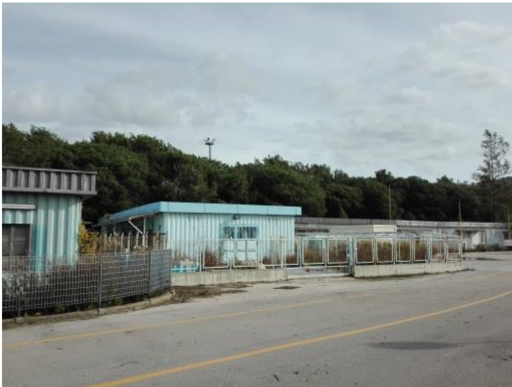
Figura 10 - Descrizione fotografica del sito
