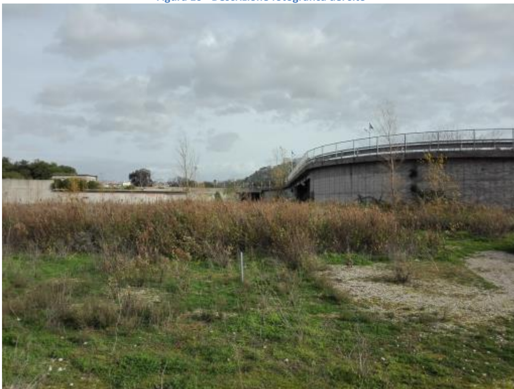
Figura 11 - Descrizione fotografica del sito
