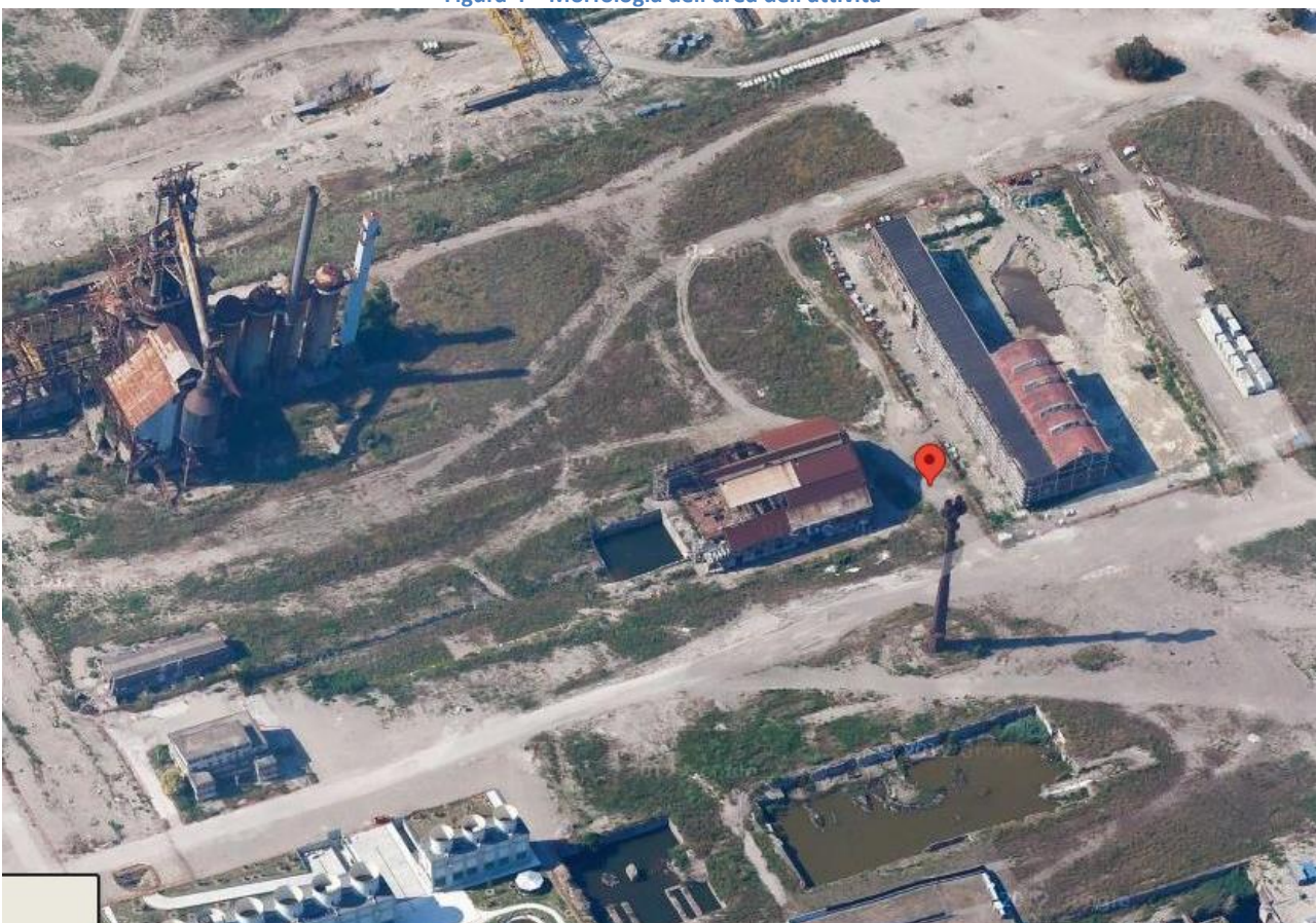
Figura 5 – Dettaglio ristretto dell'area dell'attività
