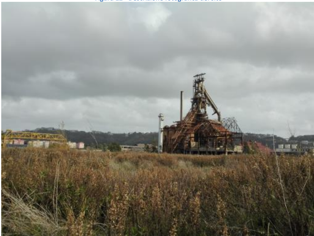
Figura 13 - Descrizione fotografica del sito
