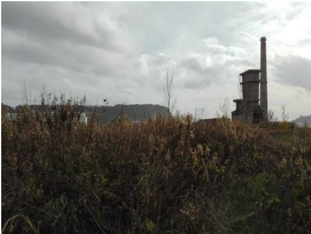
Figura 12 - Descrizione fotografica del sito
