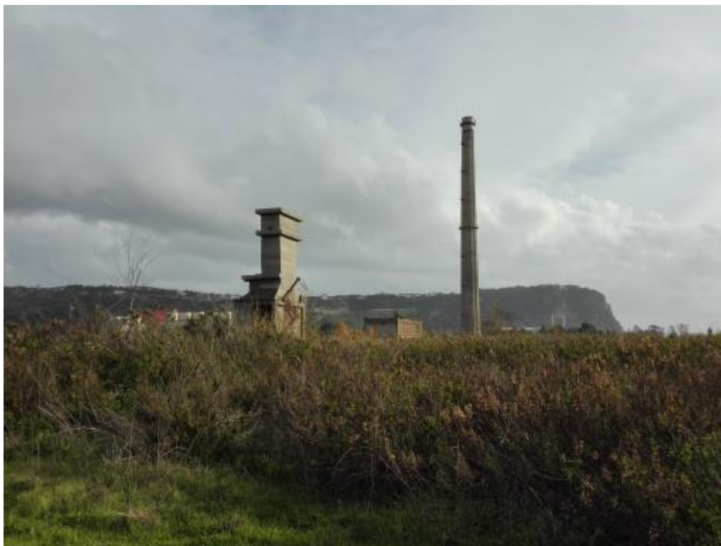
Figura 10 - Descrizione fotografica del sito
