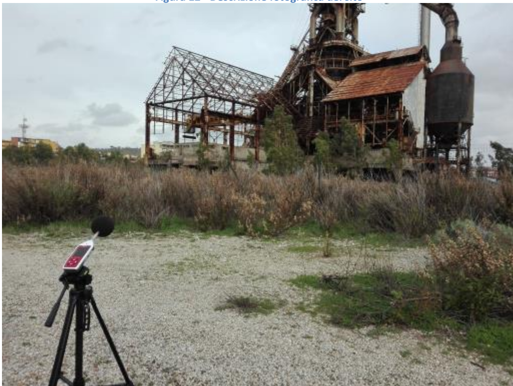
Figura 13 - Descrizione fotografica del sito
