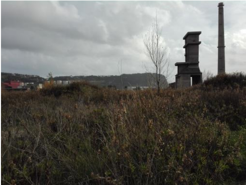
Figura 12 - Descrizione fotografica del sito
