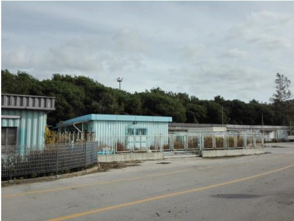
Figura 12 - Descrizione fotografica del sito
