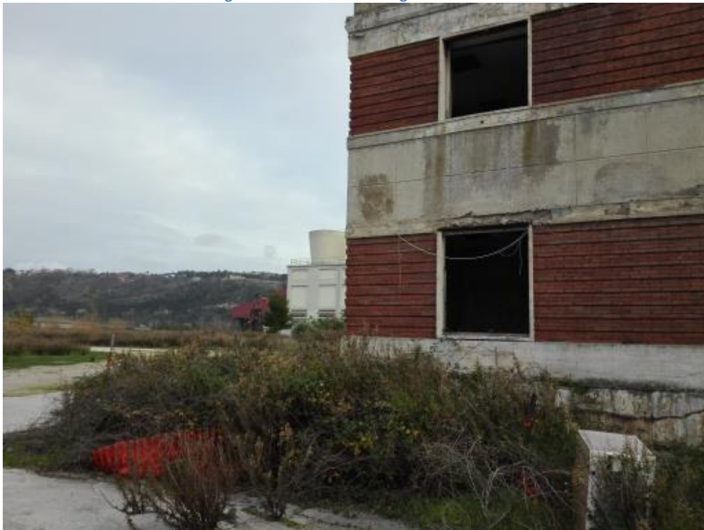
Figura 11 - Descrizione fotografica del sito
