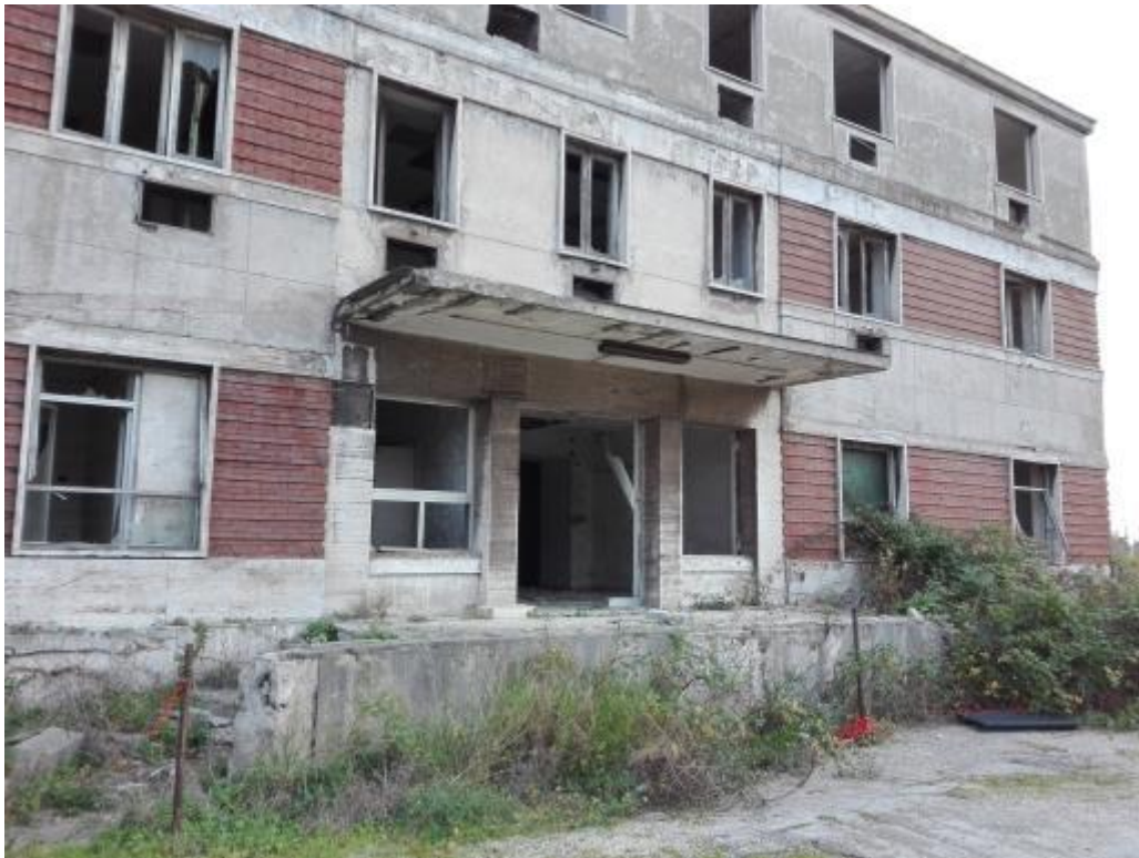
Figura 12 - Descrizione fotografica del sito
