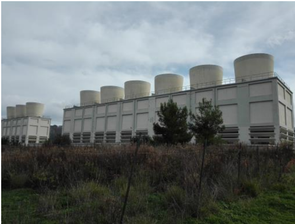
Figura 10 - Descrizione fotografica del sito
