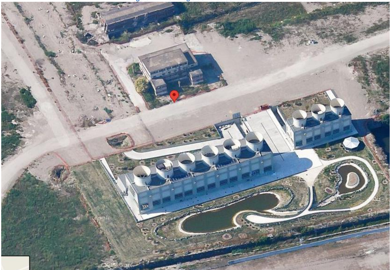
Figura 5 – Dettaglio ristretto dell'area dell'attività
