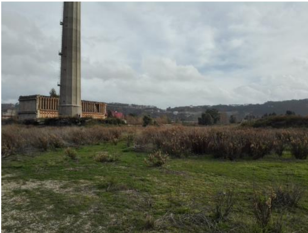
Figura 10 - Descrizione fotografica del sito
