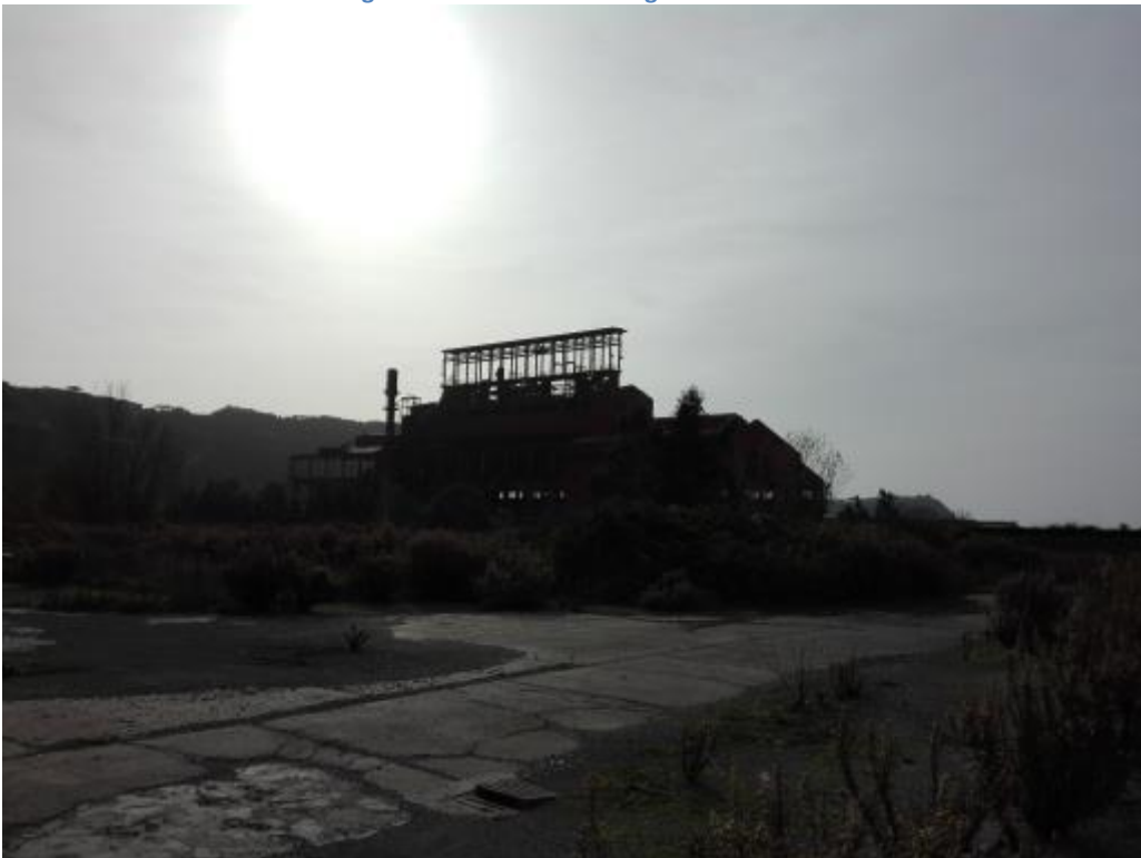
Figura 11 - Descrizione fotografica del sito
