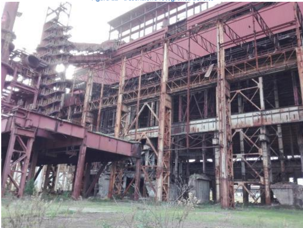
Figura 13 - Descrizione fotografica del sito
