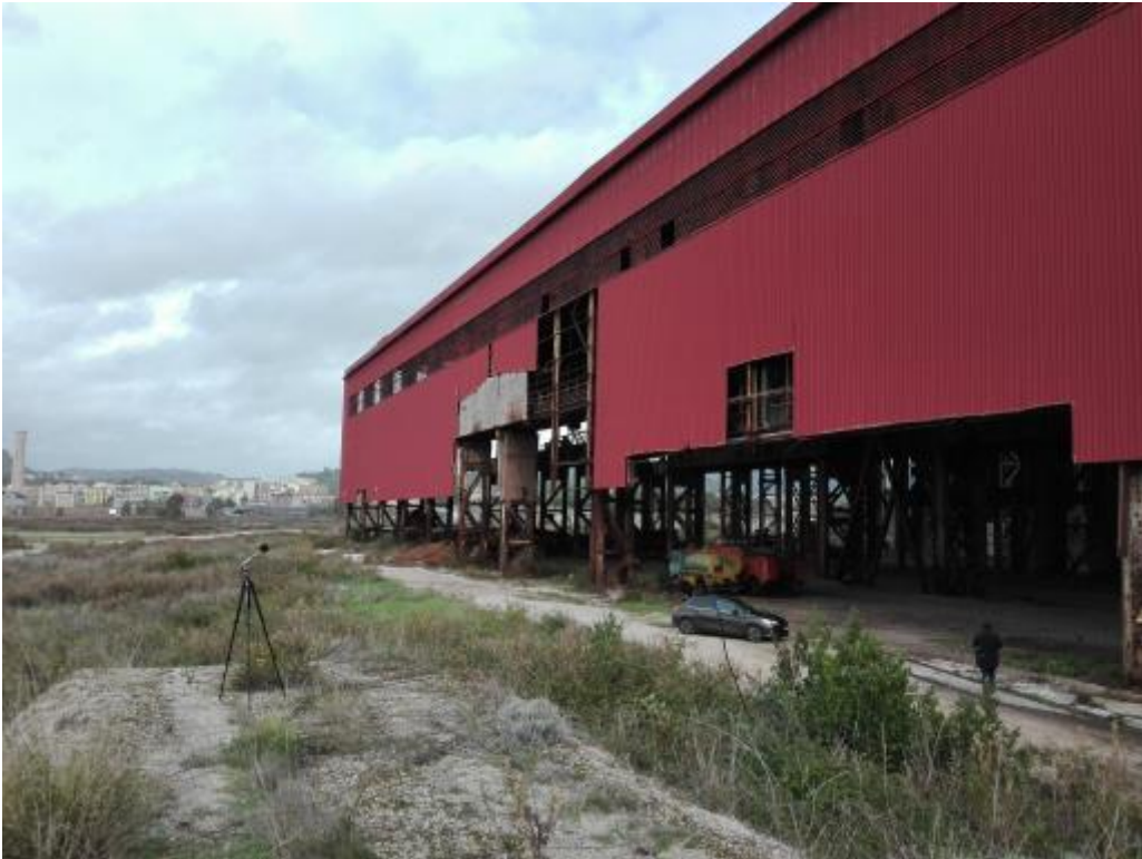
Figura 10 - Descrizione fotografica del sito
