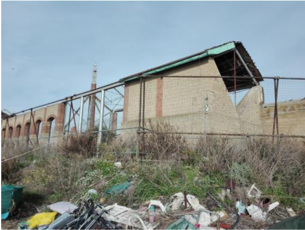
Figura 12 - Descrizione fotografica del sito
