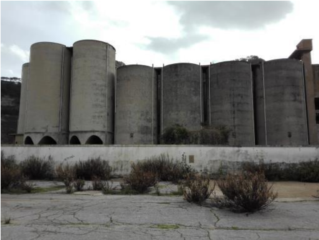
Figura 12 - Descrizione fotografica del sito
