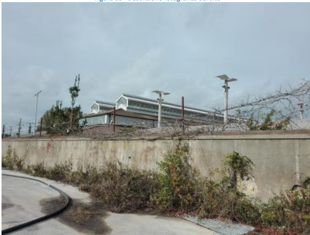
Figura 11 - Descrizione fotografica del sito
