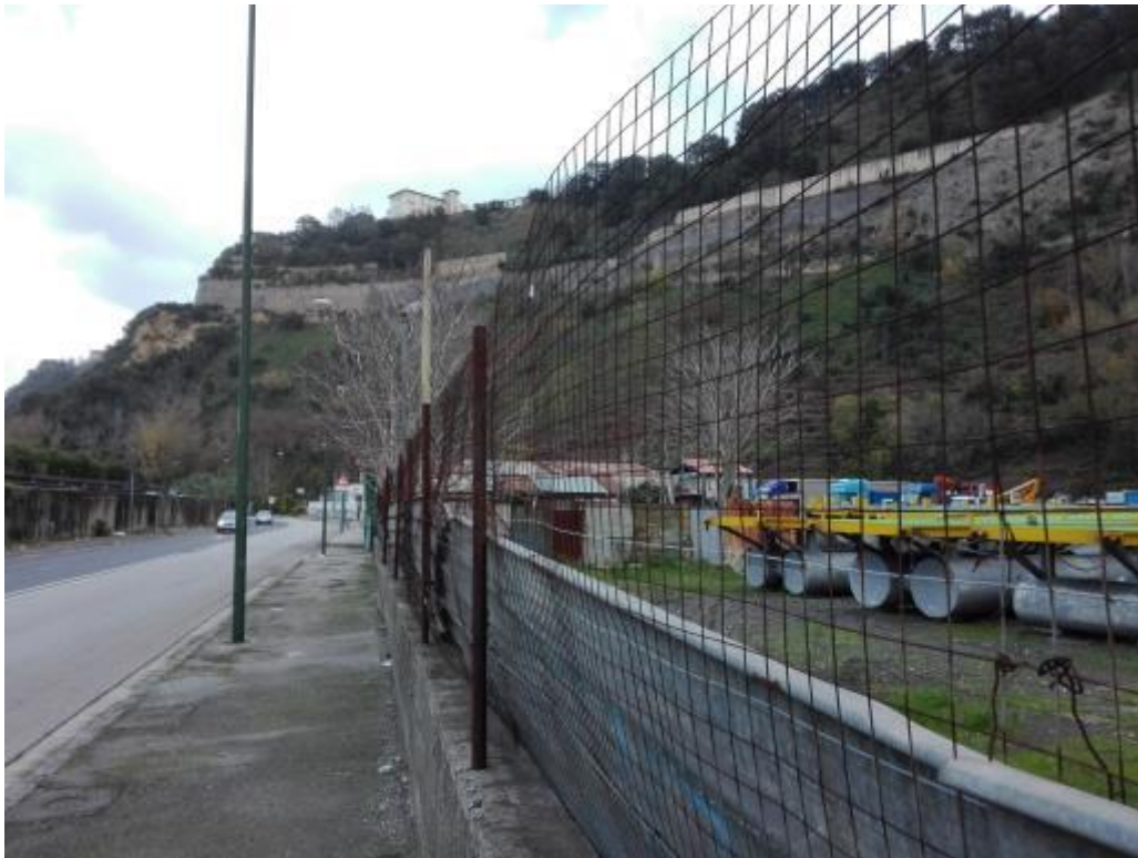
Figura 12 - Descrizione fotografica del sito
