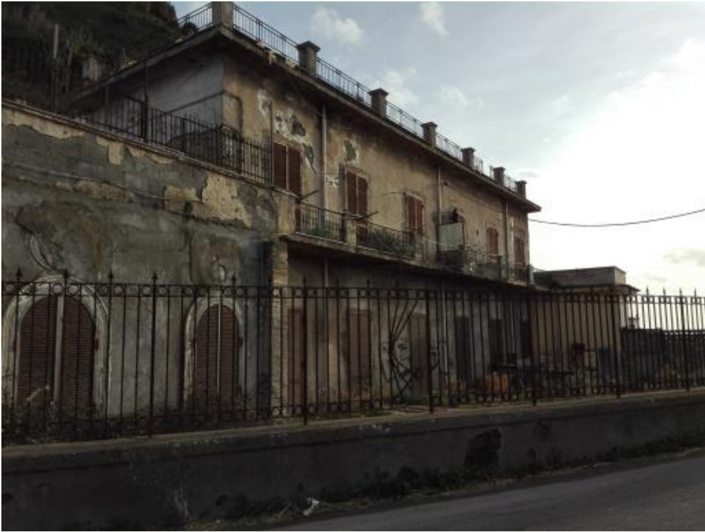
Figura 12 - Descrizione fotografica del sito
