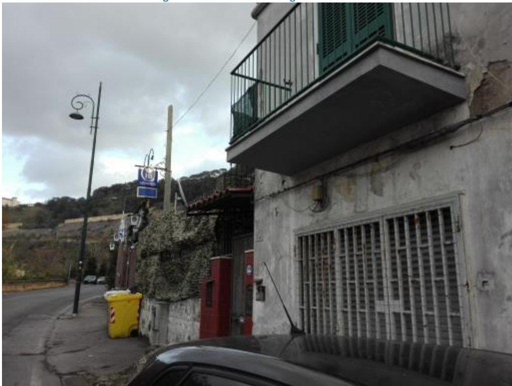
Figura 11 - Descrizione fotografica del sito
