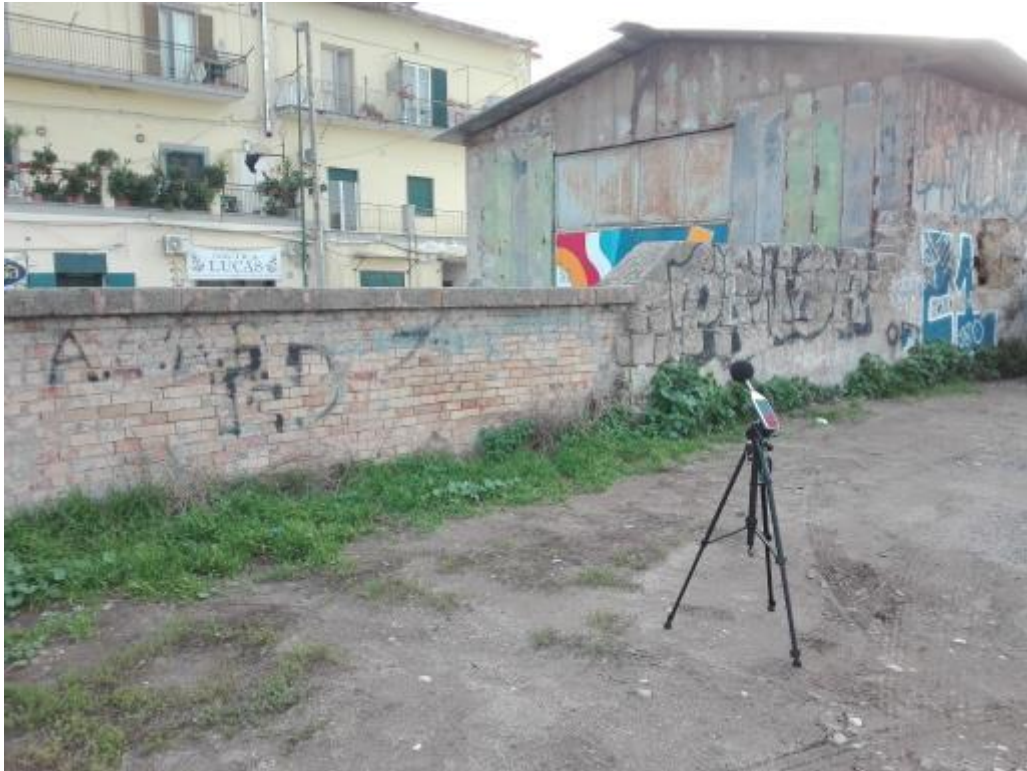
Figura 10 - Descrizione fotografica del sito
