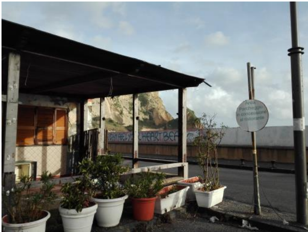
Figura 10 - Descrizione fotografica del sito
