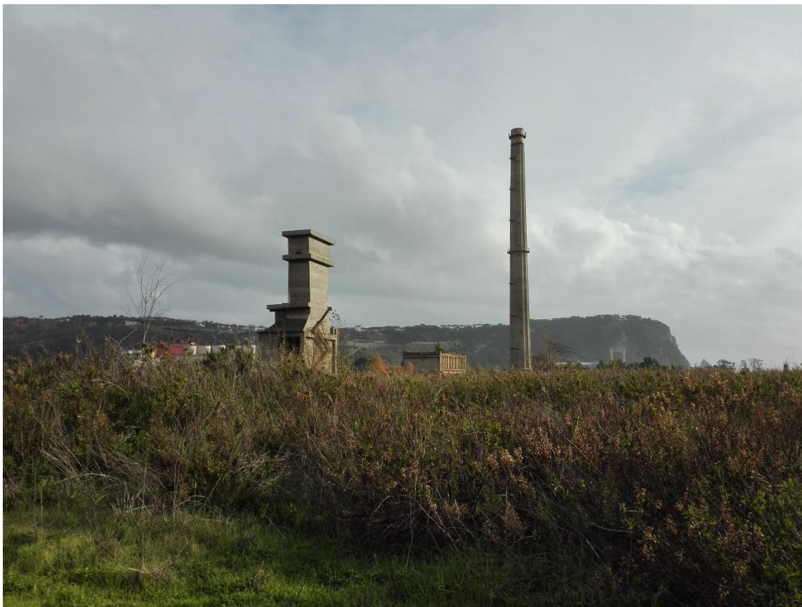
Figura 7 - Descrizione fotografica del sito
