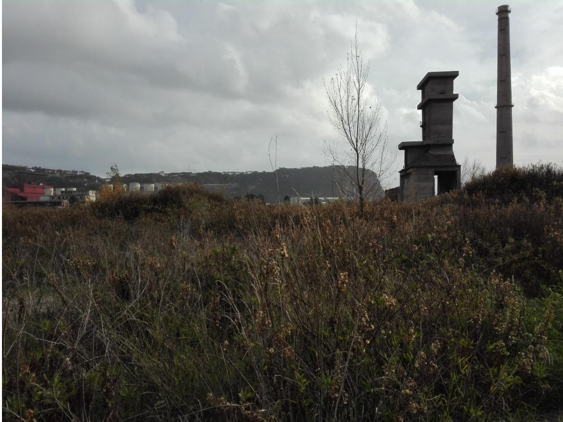
Figura 9 - Descrizione fotografica del sito
