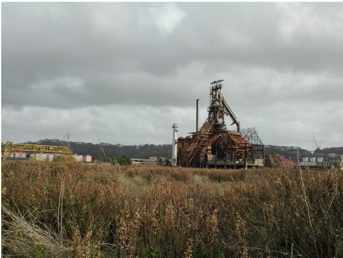
Figura 10 - Descrizione fotografica del sito
