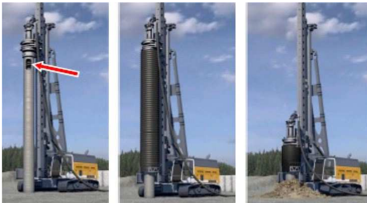
Immagine 9 – espulsione del materiale di risulta con l'uso di 2 rotary indipendenti e FoW
