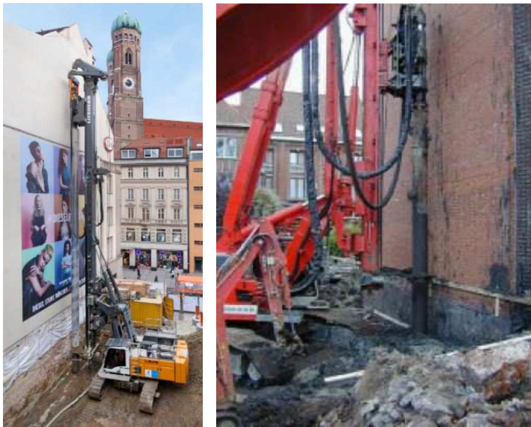
Immagine 8 – esempi di perforazioni con l'uso di 2 rotary indipendenti e FoW
