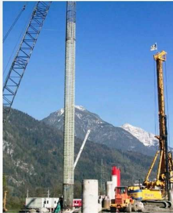
Immagine 17 –gabbia in acciaio e vetroresina per palo
