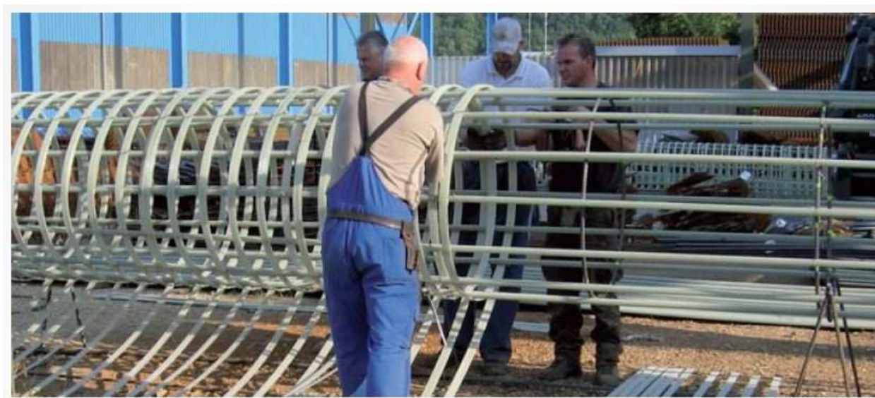
Immagine 16 – montaggio gabbia in vetroresina per pali
