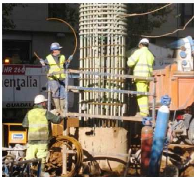
Immagine 18 – inserimento della gabbia in acciaio e vetroresina
