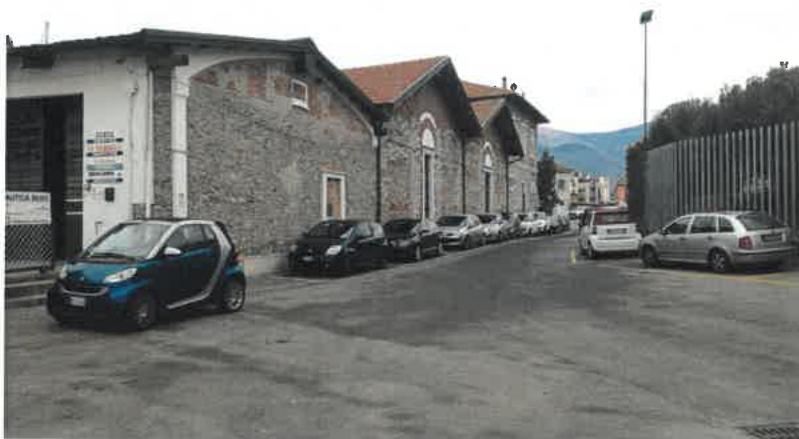
Figura 10. Vista dei capannoni di proprietà
