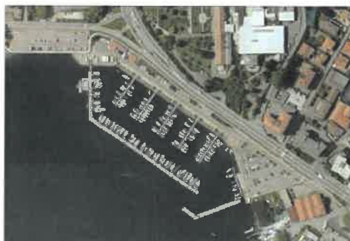
Figura 5. Vista aerea del Porto palatucci realizzato nel 2003
