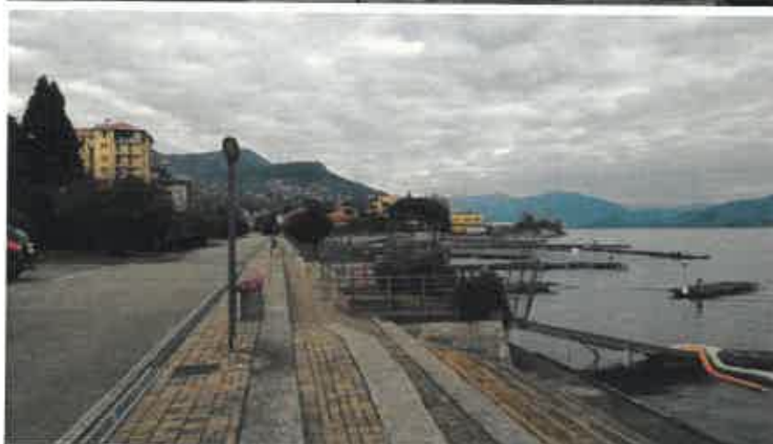
Figura 4. Vista dell'infrastruttura portuale dismessa
