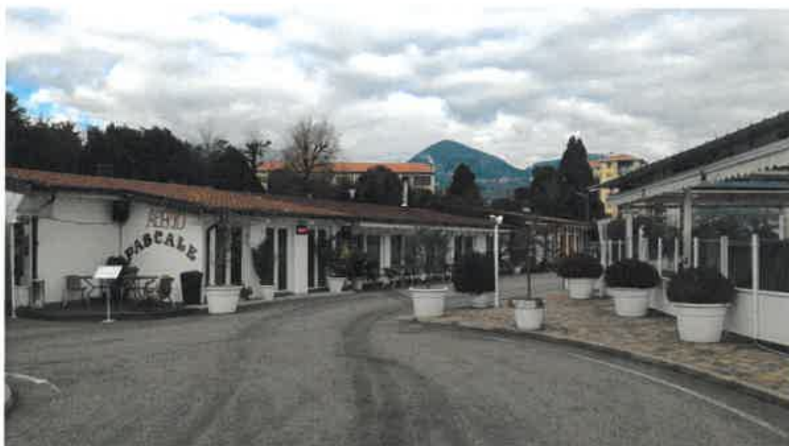
Figura 12. Vista dell'accesso SO all'area di progetto
