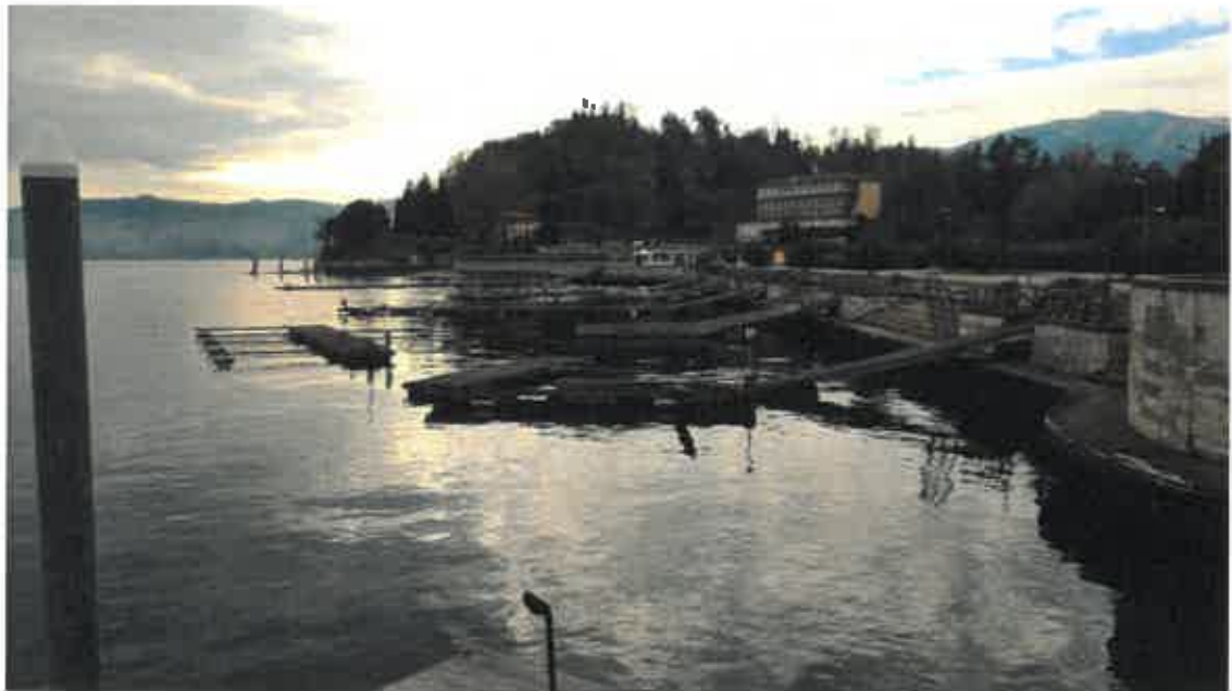
Figura 15. Vista dell'infrastruttura portuale dismessa
