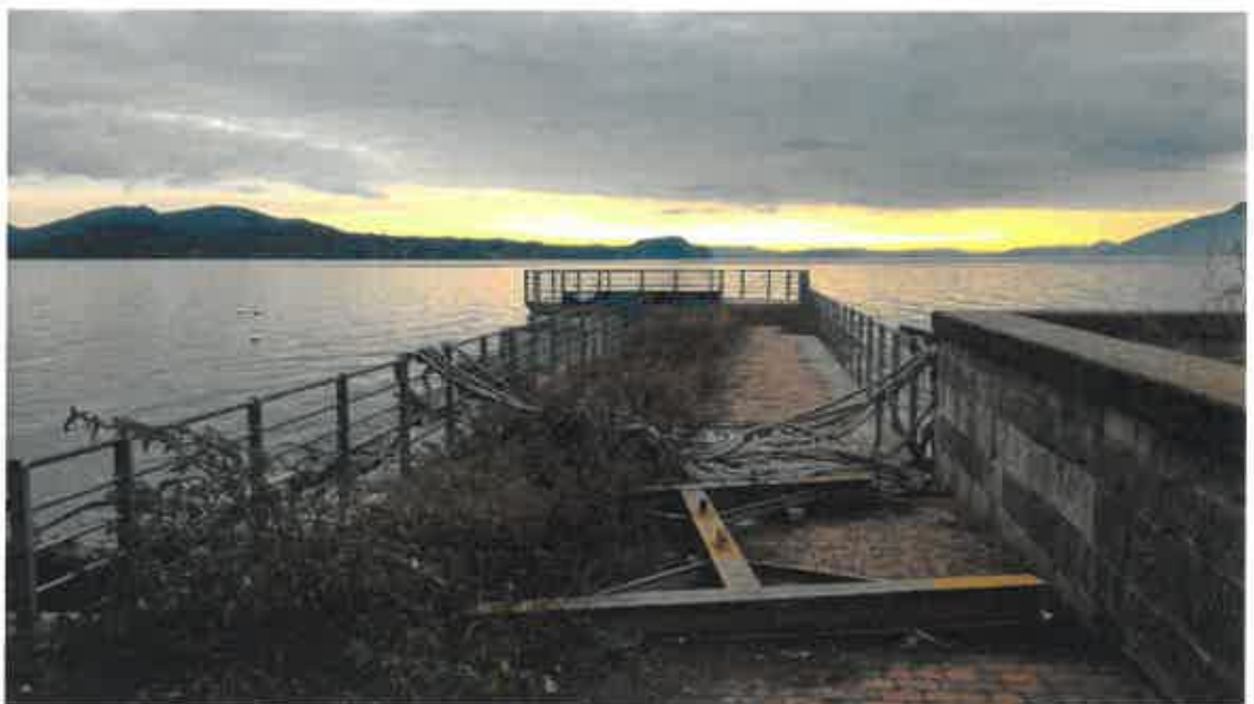
Figura 16. Vista del molo in muratura
