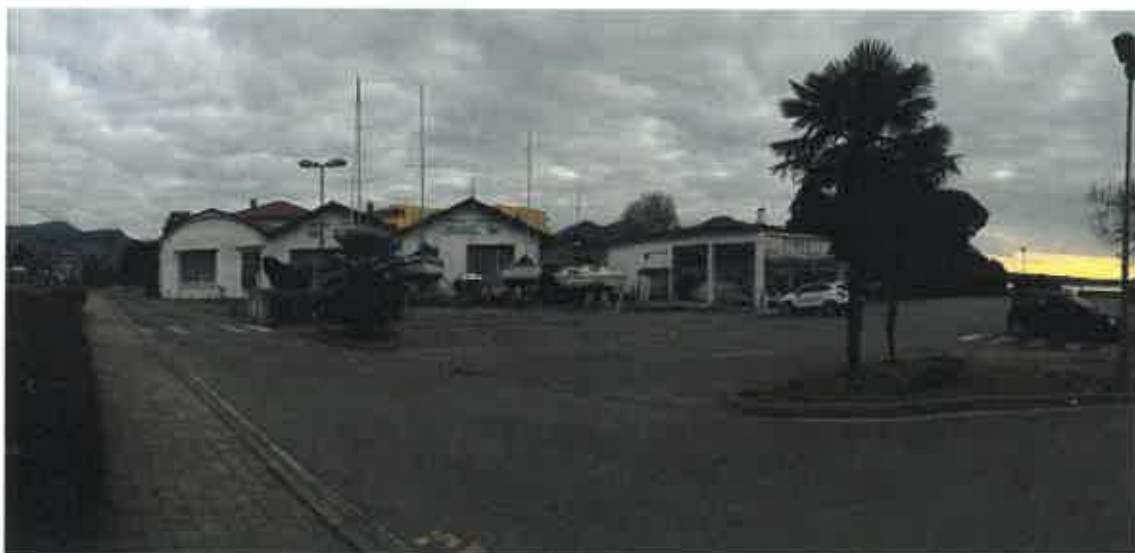
Figura 11. Vista dei capannoni di proprietà
